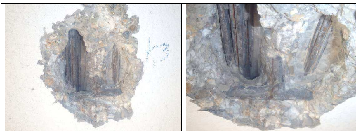
Obr. 32 Overenie stavu predpínacej výstuže v mieste „K2“
