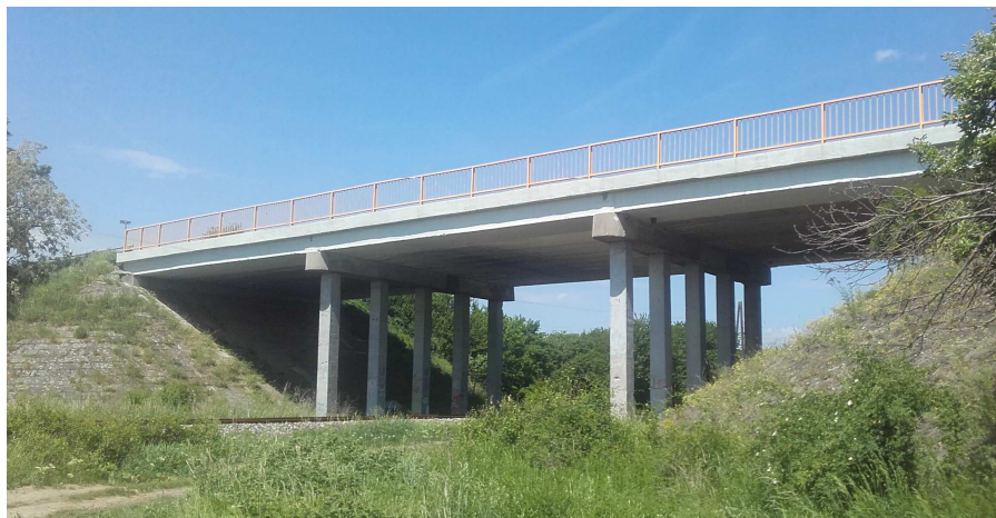
Obr. 45 Pohľad na mostnú konštrukciu
