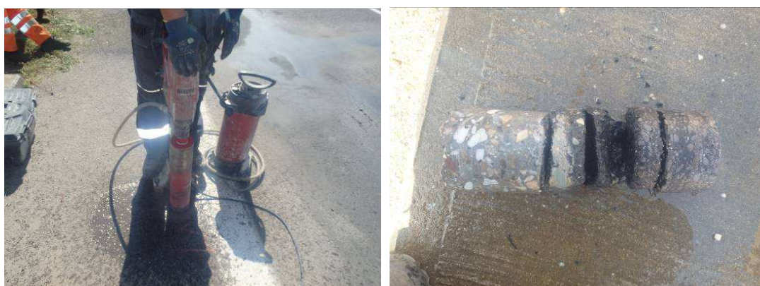
Obr. 15 Sonda do vozovky
