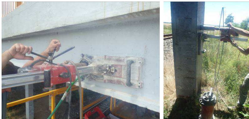
Obr. 8 Odber vzoriek betónu jadrovou vŕtačkou
