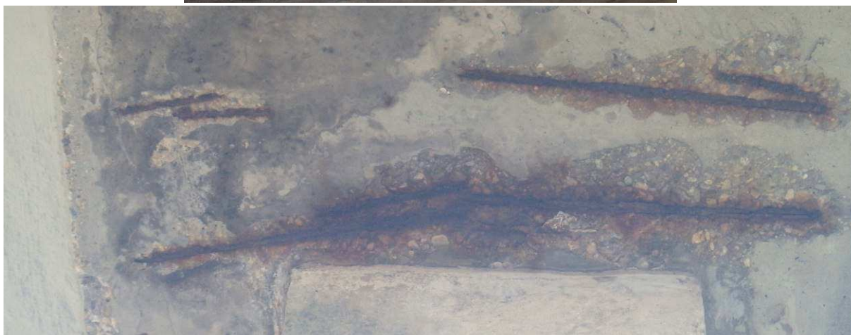
Obr. 23 Vystuženie úložného prahu
