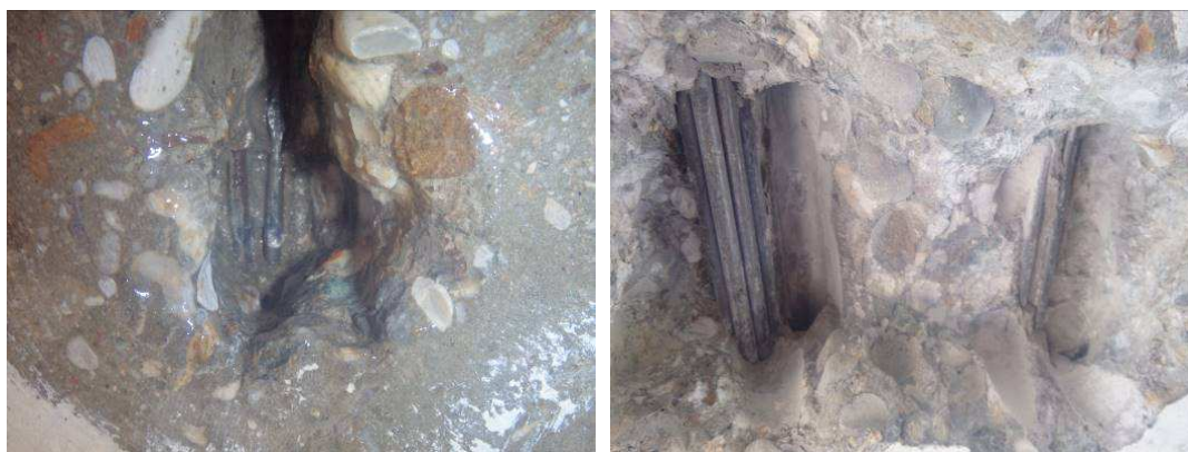
Obr. 14 Odkryté predpínacie káblové kanáliky
