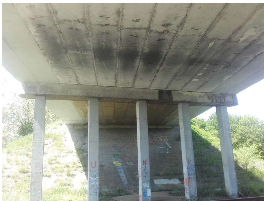
Obr. 46 Pohľad na nosný systém mosta
