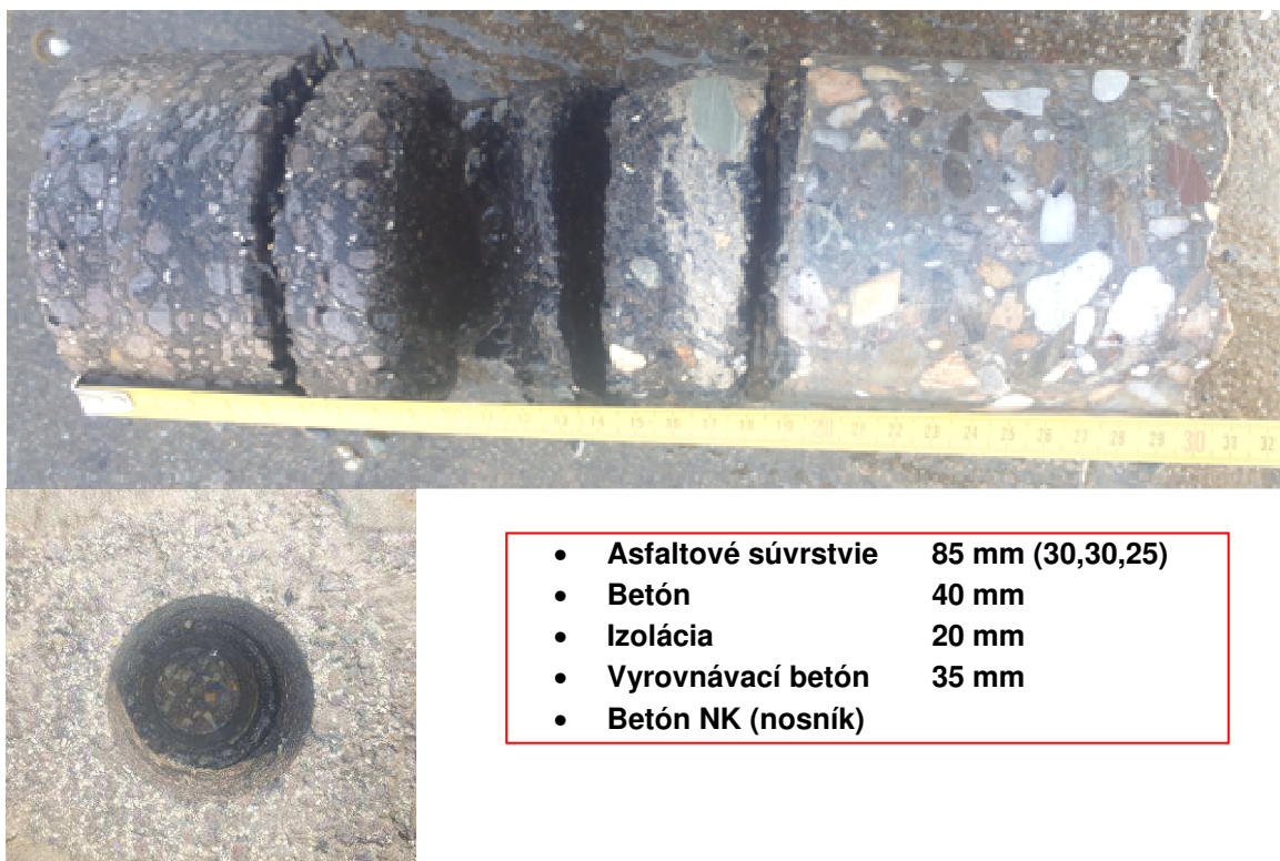
Obr. 28 Sonda do vozovky S1
