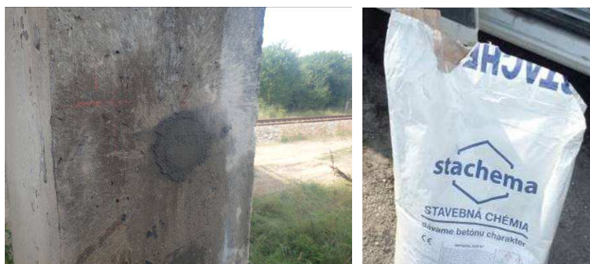
Obr. 9 Oprava povrchu po odbere jadrových vývrtov
