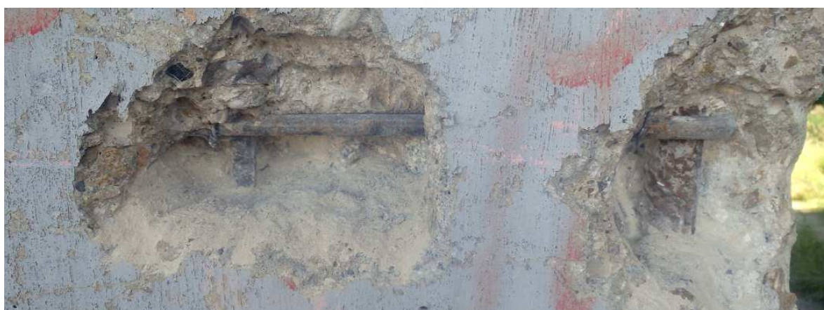
Obr. 19 Vystuženie vnútorného stĺpa
