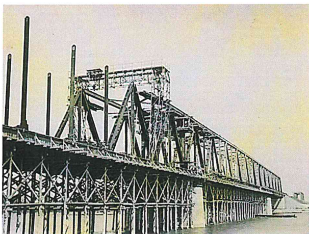
2. kép: Medvei Duna-híd építése, teljes beállványozás
