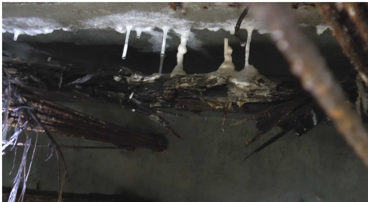
Obr. 22 Inkrustácie v komore
