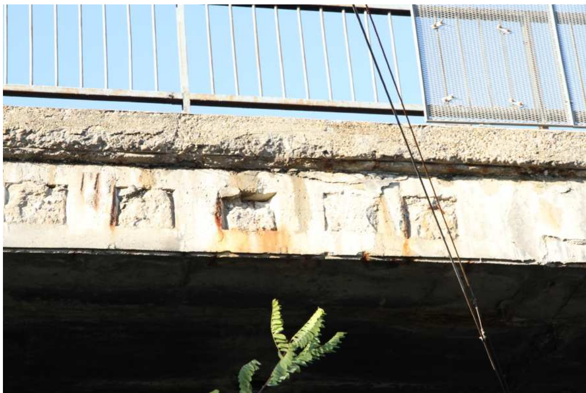
Obr. 28 - Krajný nosník – odhalené kotvy priečneho predpätia
