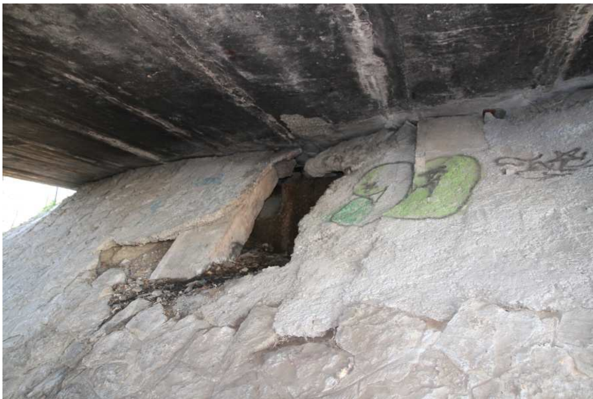
Obr. 31 - Prepadnutý obklad svahu
