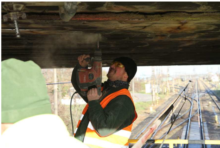
Obr. 4 Odkrývanie kanálika
