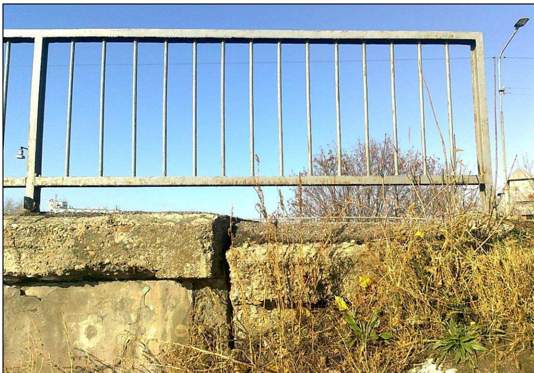
Obr. 23 - vodivé prepojenie mosta s okolitým prostredím
