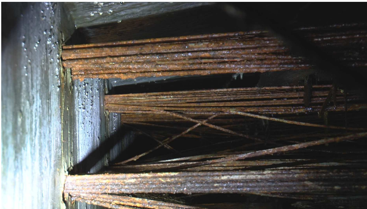
Obr. 17 Stav priečného predpätia v komore – hĺbková korózia, niektoré drôty úplne prekorodované
