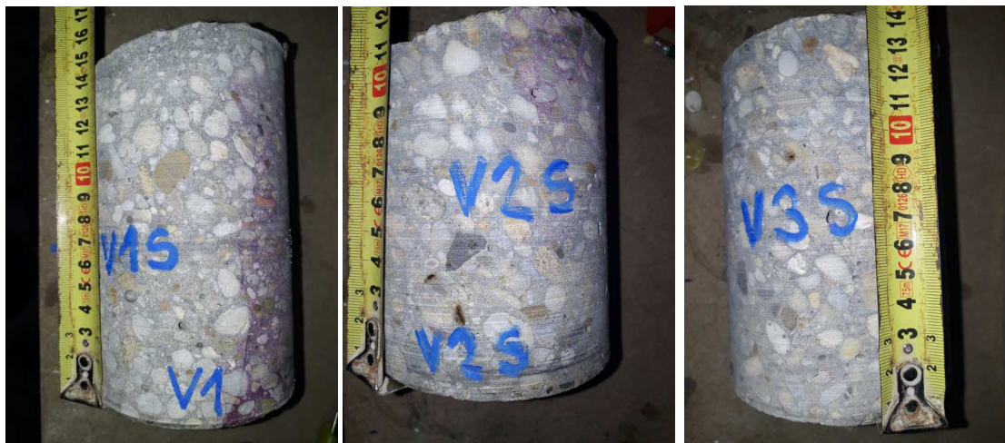
Obr. 24 Odobraté jadrové vývrty z konštrukcie
