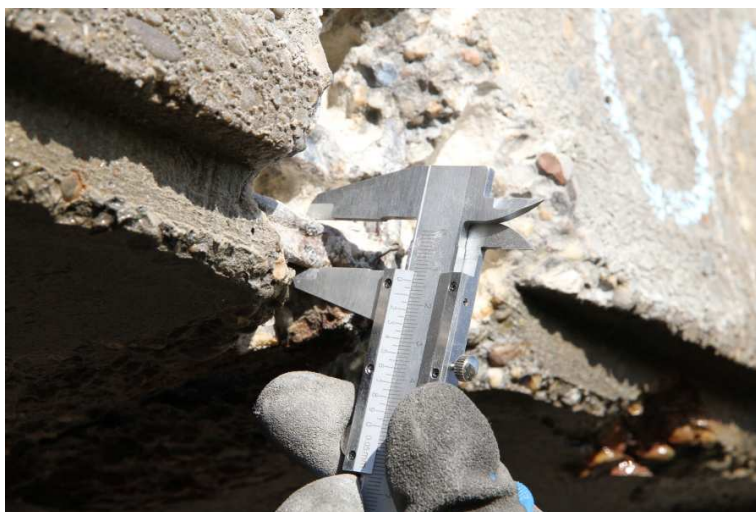
Obr. 3 Po odkrytí boli parametre výstuže merané šublerou
