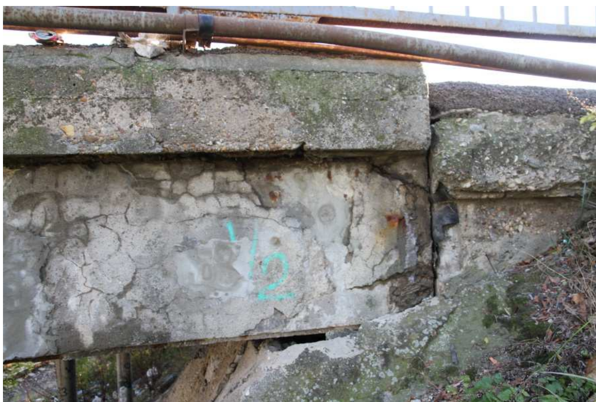
Obr. 29 - Výškový rozdiel medzi koncom nosnej konštrukcie a oporou
