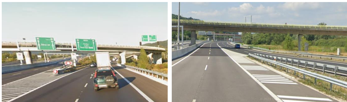
Obrázok 39 – Pohľad na čelo jazyka ostrovčeka pri rozpojení (vľavo) a spojení (vpravo) diaľnic D1 a D3 (Zdroj: https://www.google.com )
