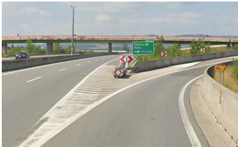
Obrázok 31 – Pohľad na čelo jazyka ostrovčeka pri odpojení jednosmernej jednopruhovej vetvy - križovatka diaľnice D1 s cestou II/507, Bytča (Zdroj: https://www.google.com/maps/ )
