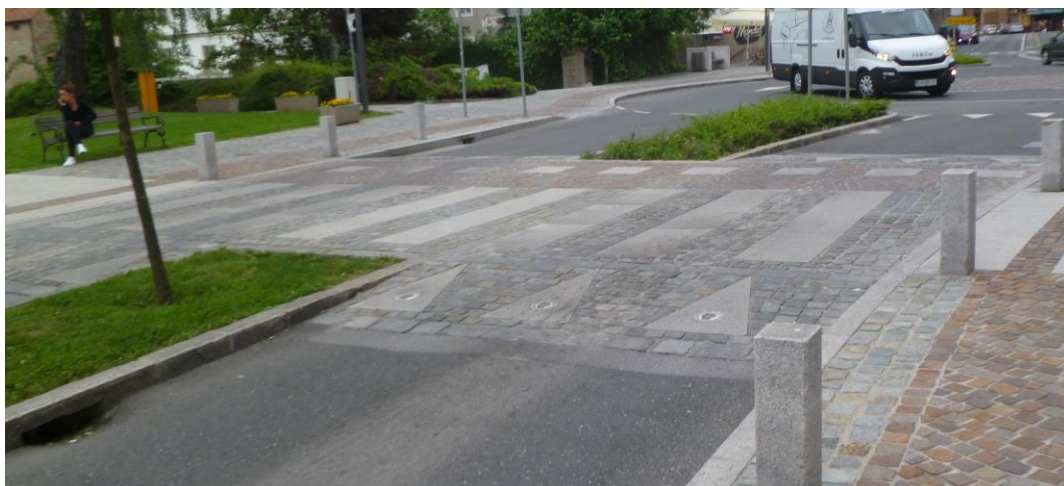
Obrázok 6.11 Vyvýšené platformy na priechochode (Slovinsko)
