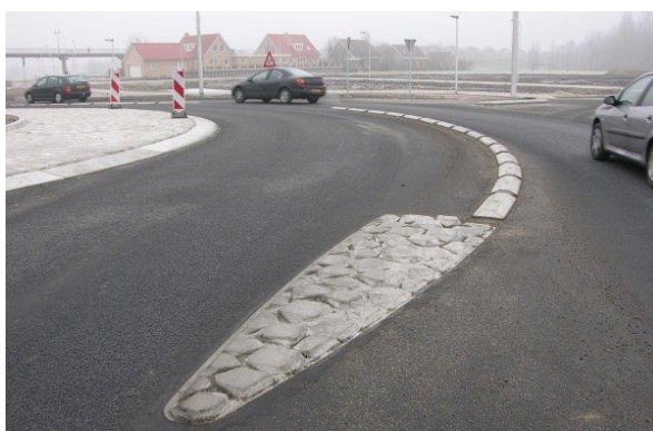
Obrázok 6.7 Rozšírená časť fyzického oddelenia jazdných pruhov (Slovinsko)
