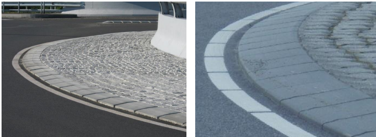
Obrázok 4.11 Spevnená prejazdňá časť stredového ostrovčeka (príklad zo Slovinska a Holandska)
