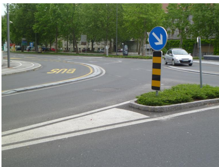
Obrázok 4.14 Deliaci ostrovček trojuholníkového tvaru (príklad zo Slovinska)
