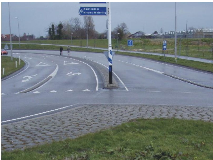
Obrázok 4.15 Kvapôčkovitý ostrovček s vylúčením chodcov a cyklistov (príklad z Holandska)
