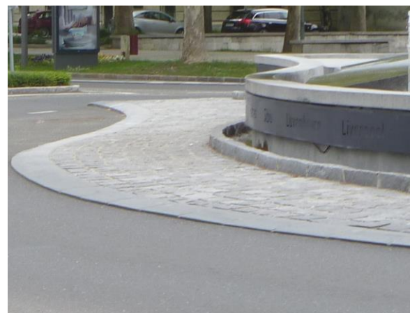
Obrázok 6.8 Detail usporiadania spevnenej časti stredového ostrovčeka (Slovinsko)
