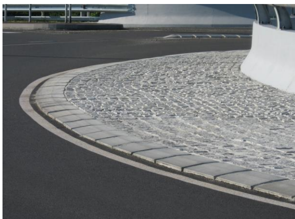
Obrázok 6.8 Detail usporiadania spevnenej časti stredového ostrovčeka (Slovinsko)
