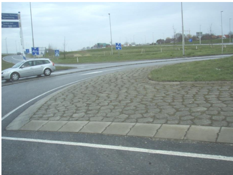
Obrázok 4.9 Časti stredového ostrovčka v TOK (spevnená prejazdná časť, stredový ostrovček - neprejazdná časť), príklad z Holandska
