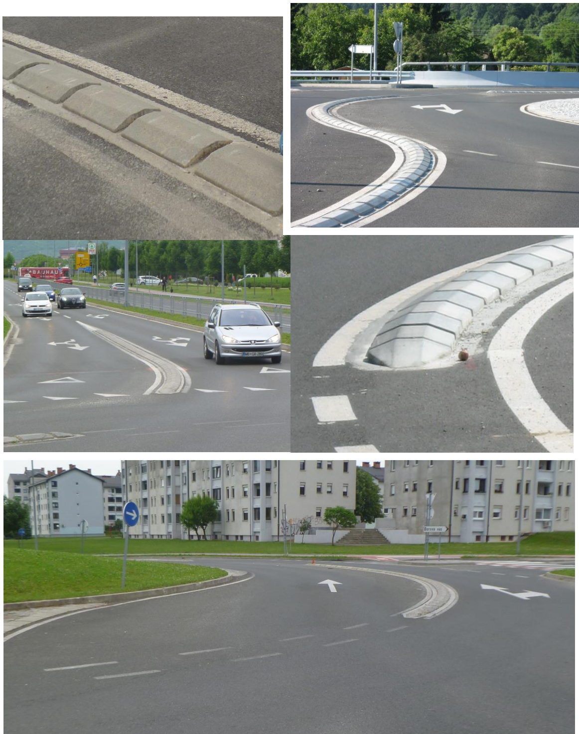
Obrázok 6.6 Fyzické oddelenie jazdných pruhov - líniový oddeľovač (Slovinsko)
