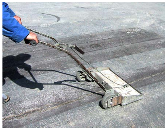
Zbieranie zvyšných oceľových guľčiek magnetickým zberačom
