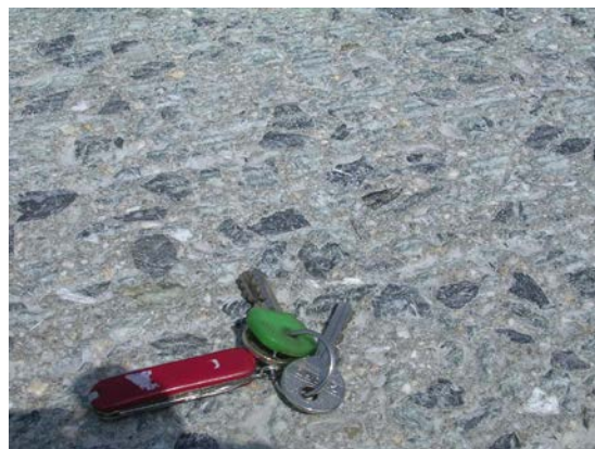
Stav povrchu po frézovaní
