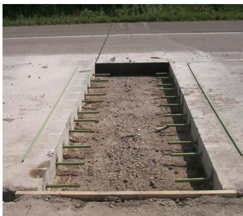
Priebeh výmeny časti dosky pri priečnej škáre (vľavo osadenie klznými tržmi, vpravo kotvami)
