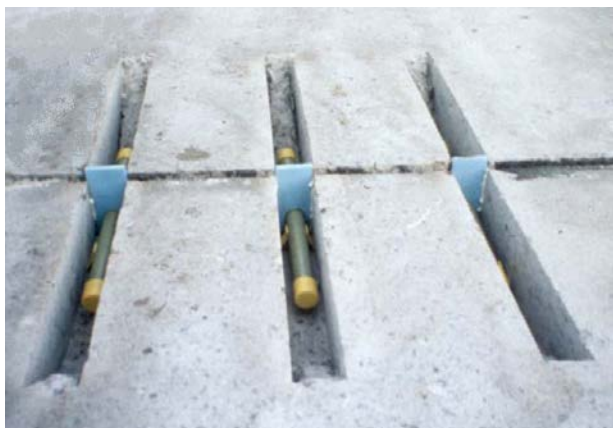
Inštalácia klzných trňov pred vyplnením drážok, viditeľné osadenie pružných vložiek
