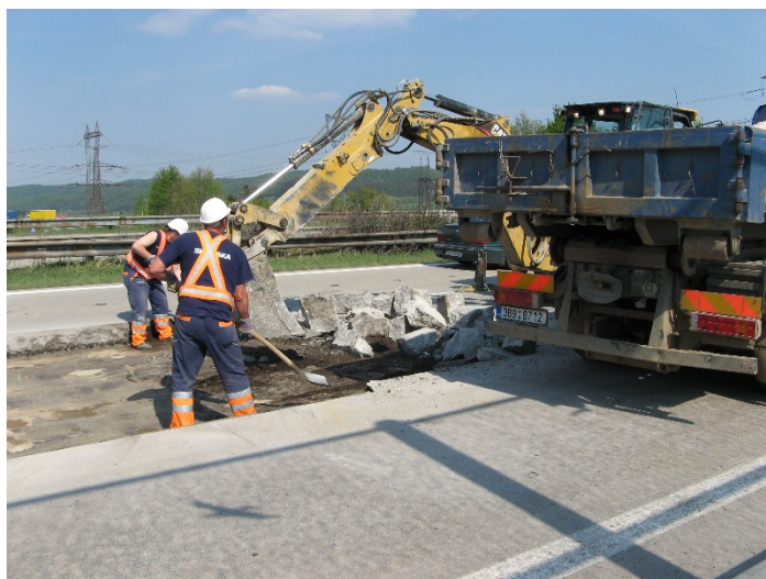
Vybúranie starých betónových dosiek
