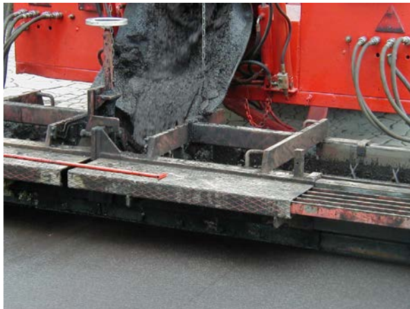
Pohľad na úpravu po rozprestrení mikrokoberca
