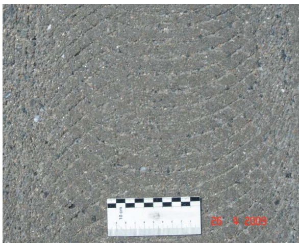
Stav povrchu po skončení zdrsňovania
