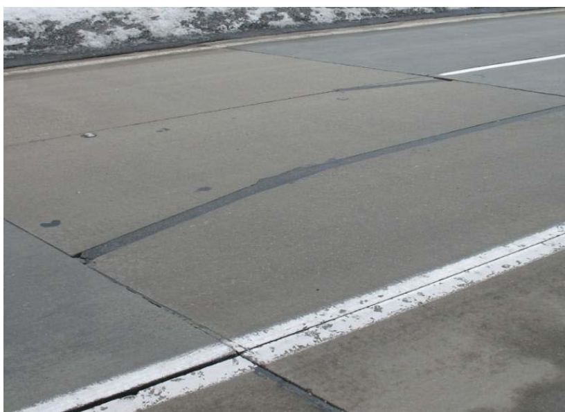
Úprava pasívnej trhliny prerezaním a utesnením zálievkovou hmotou
