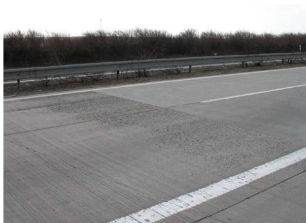
Odstránenie schodov na priečnej škáre frézou
