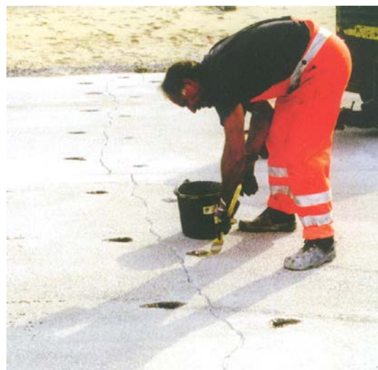
Doplnenie vrtov polymérnou maltou a zarovnanie s povrchom dosky
