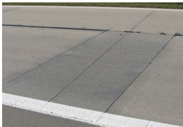
Vyhotovená výmena časti dosiek pri priečnej škáre (v jednom jazdnom pruhu)
