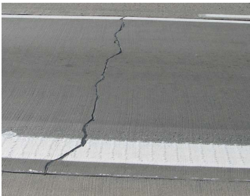
Utesnenie pasívnej trhliny bez rozšírenia
