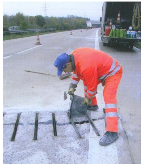
Priebeh kotvenia trhliny pomocou horizontálnych kotiev
