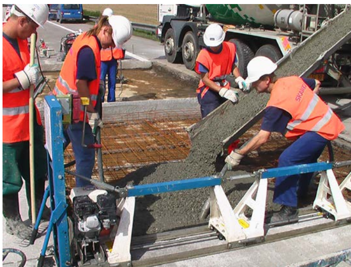
Betonáž jednotlivých nových dosiek
