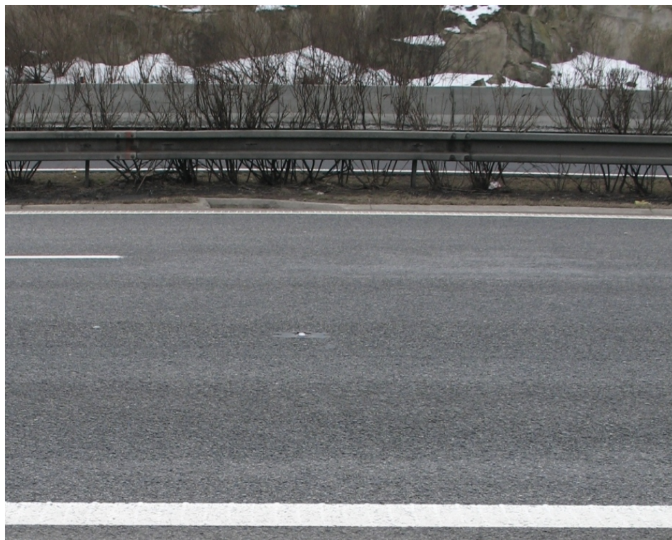
Príklad prekrytia vozovky asfaltovou vrstvou hr. 40 mm
