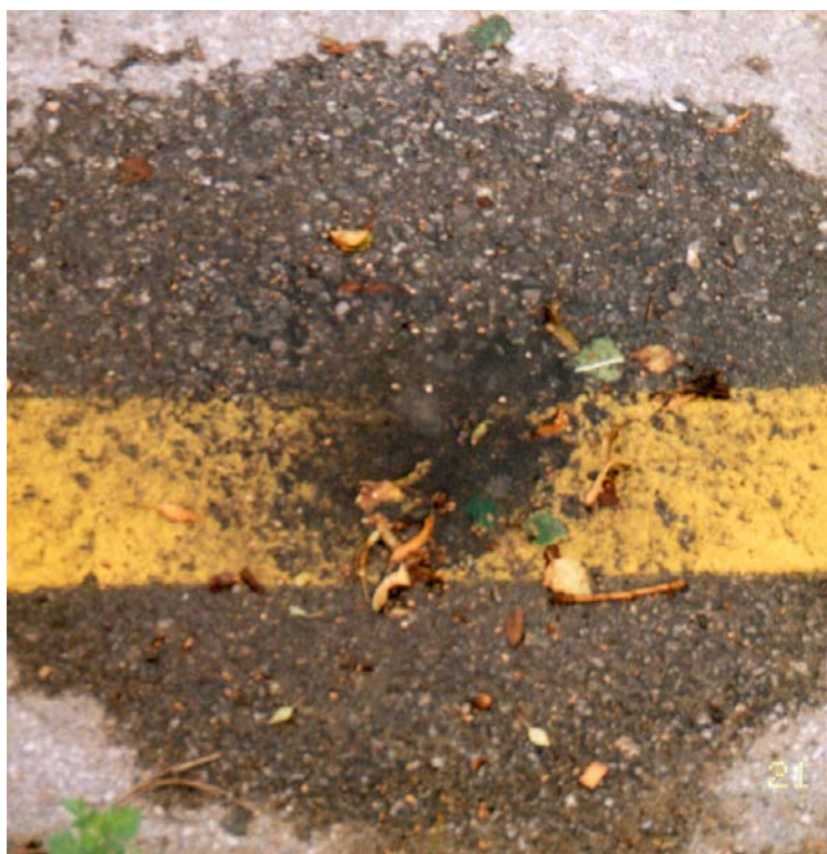
Prekrytie odvodňovača vrstvou vozovky
