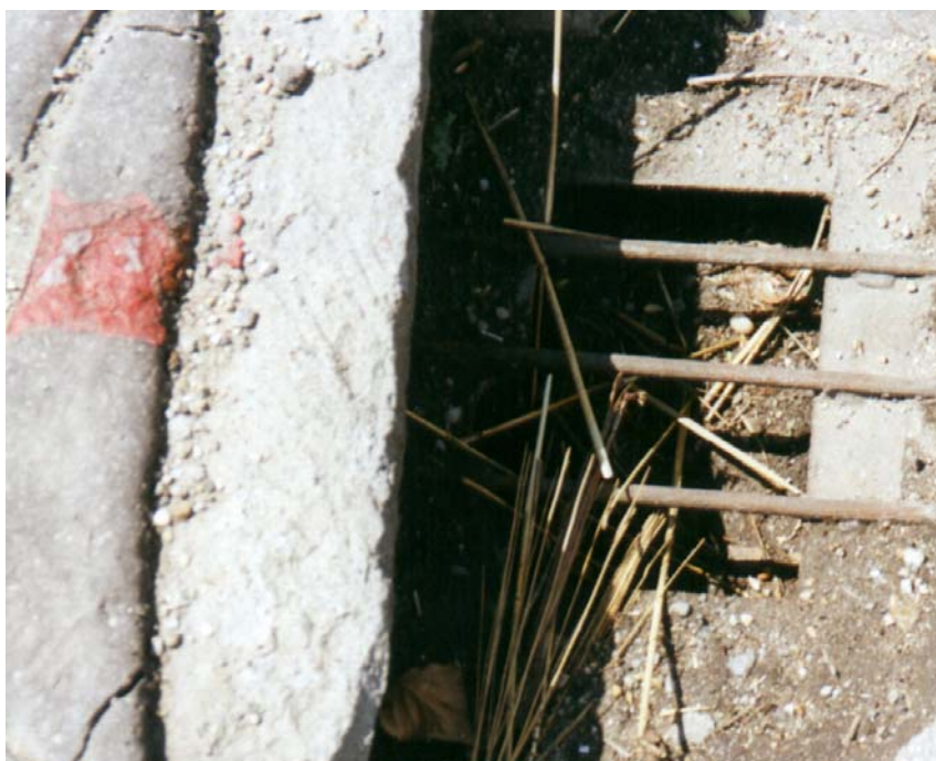
Upchatý odvodňovač
