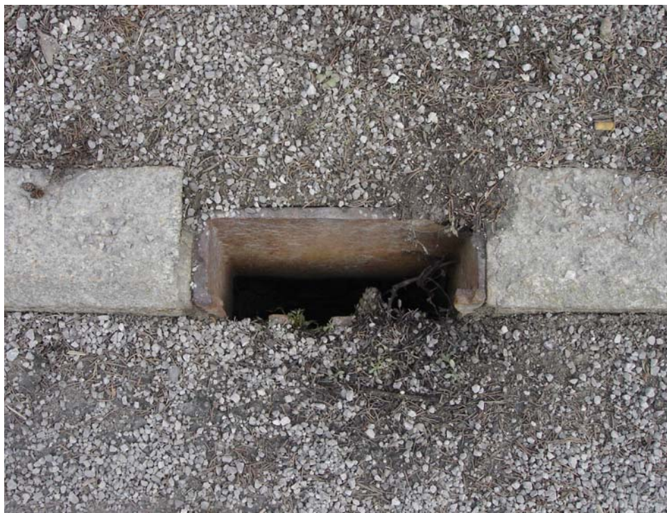
Poškozený odvodňovač
