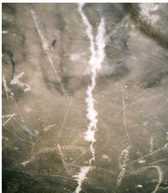
Pozdĺžne trhliny v doske nosnej konštrukcie
