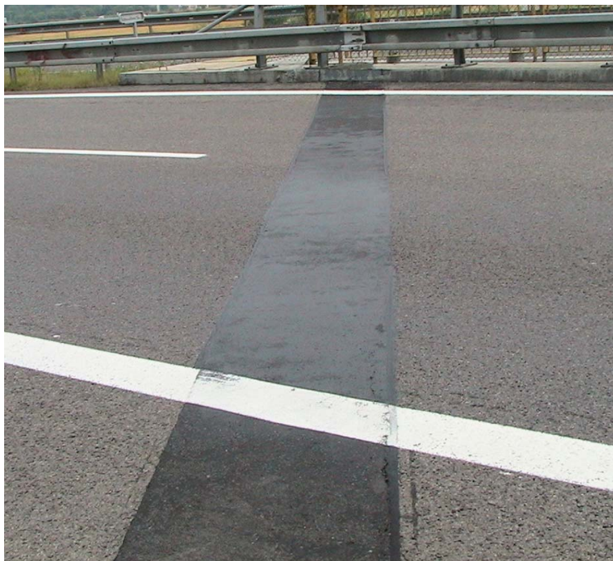
Vyhľadanie asfaltového mostného záveru
