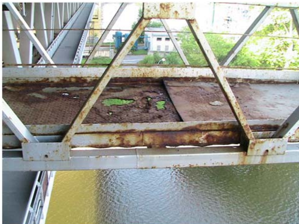
Nebezpečie úrazu – porušenie bezpečnosti při práci
