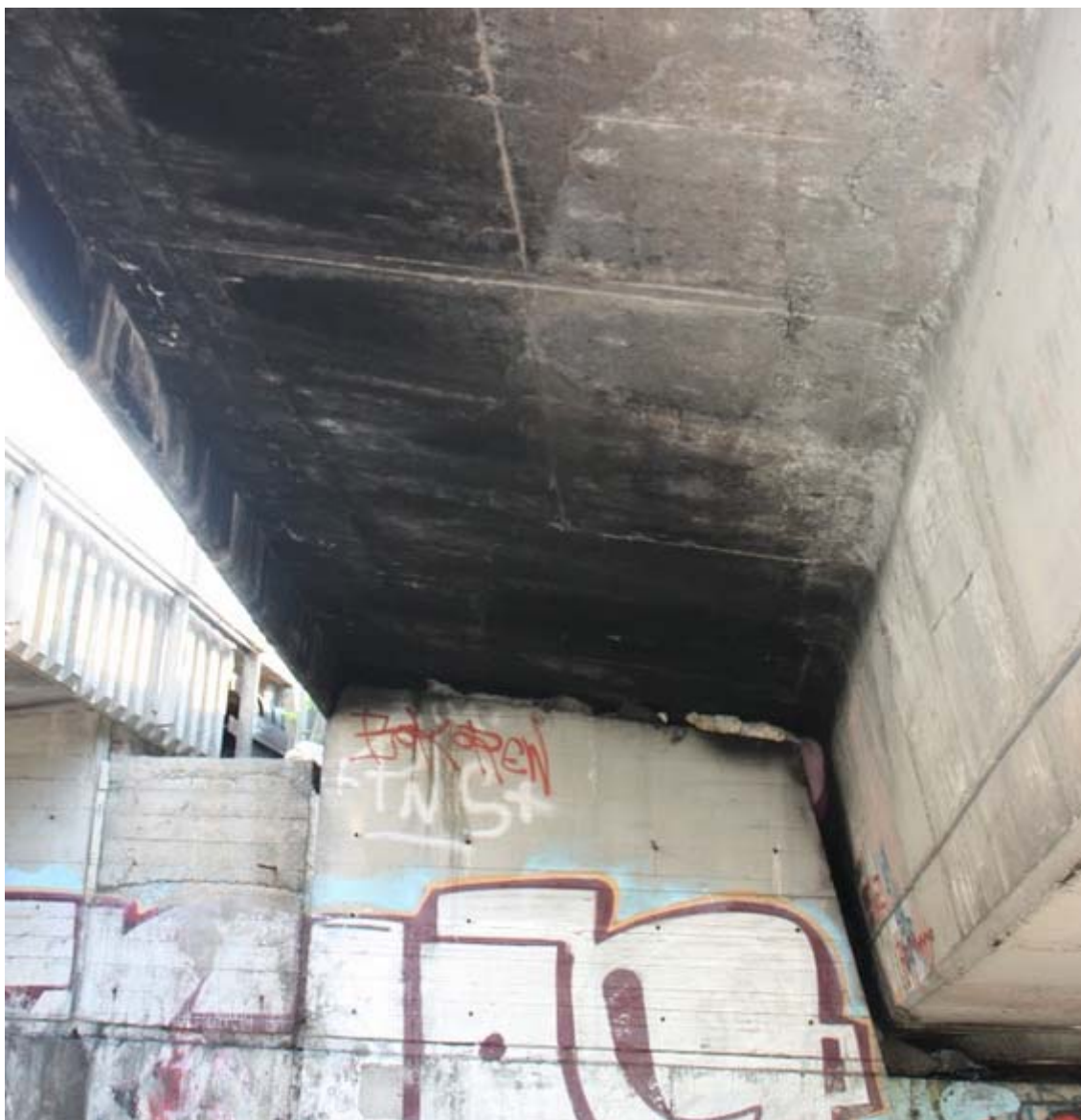
Znečistenie dymovými splodinami
