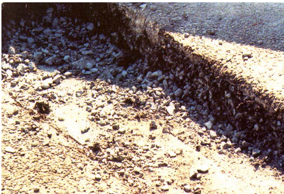
Oblast' mostného záveru po odtrhnutí a odstránení
