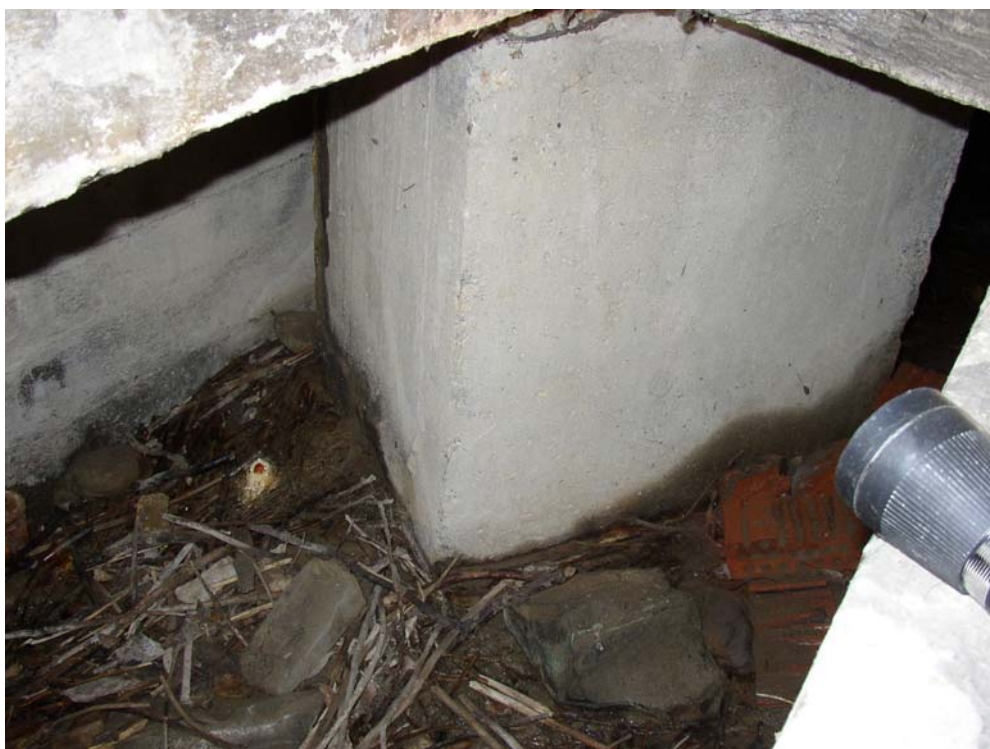
Znečistenie v oblasti kyvného ložiska
