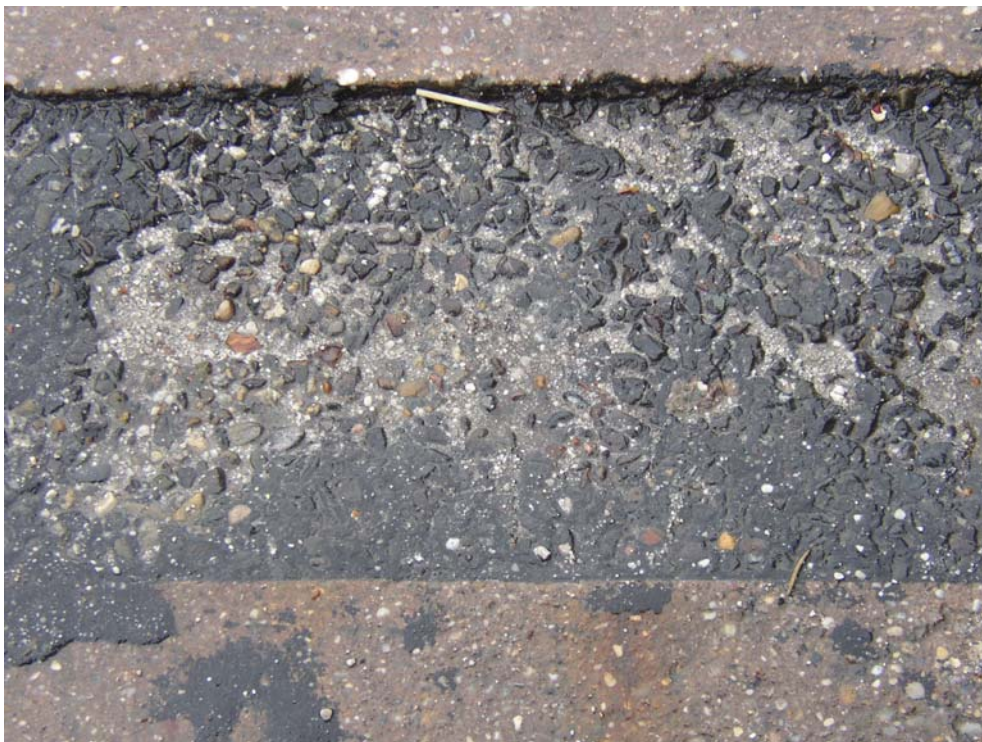
Stlačenie asfaltového záveru
