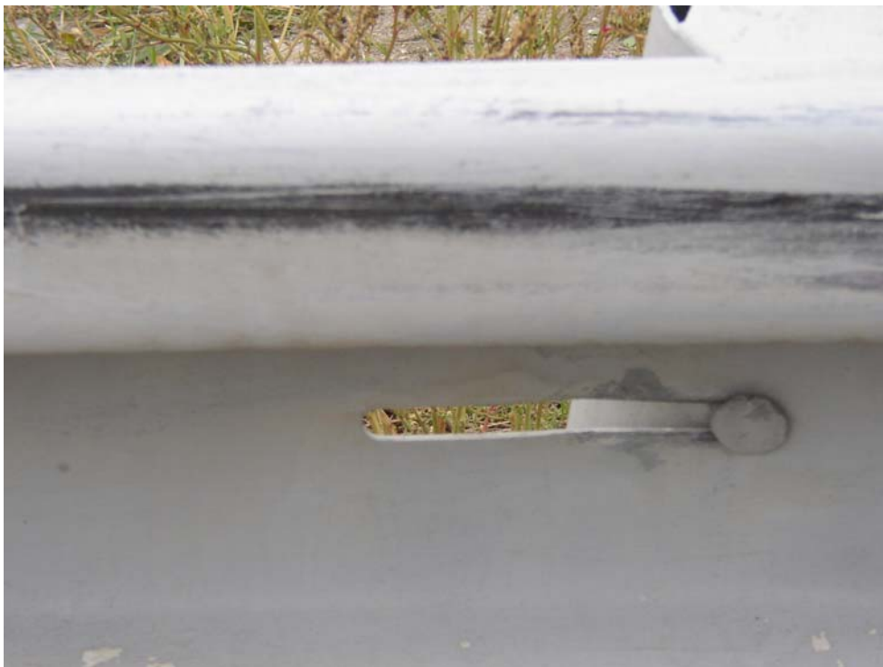
Poškodenie metalizácie
