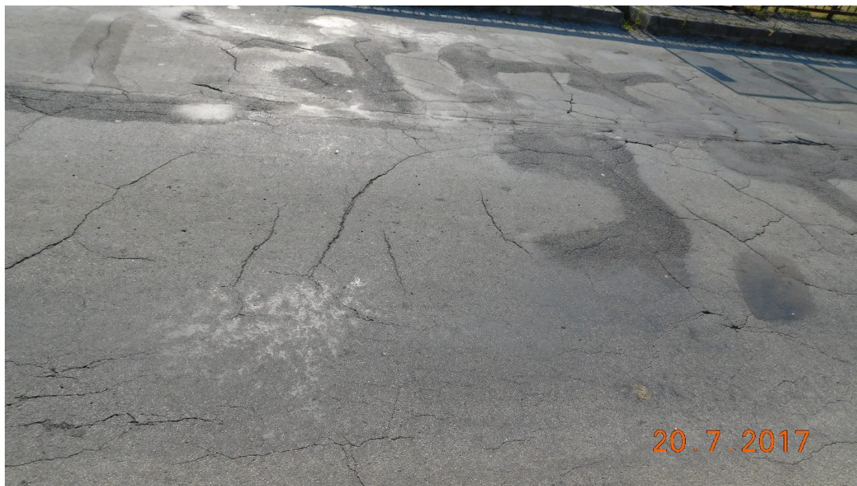
Nepravidelné trhliny
