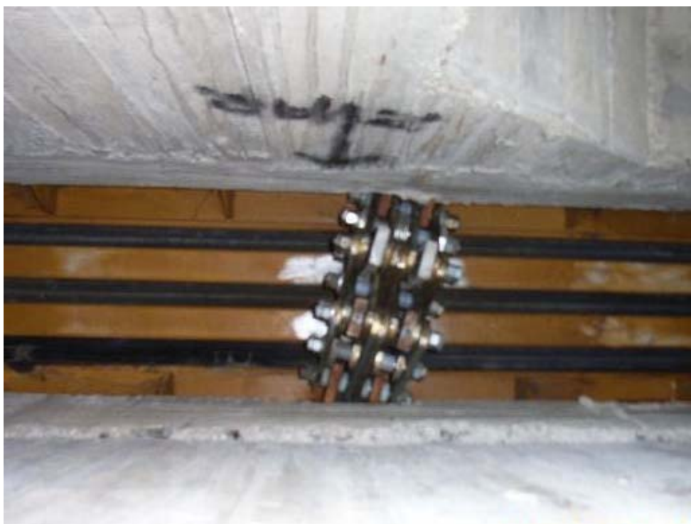
Priečne ušmyknutie s poruchou nožnicového mechanizmu MZ
