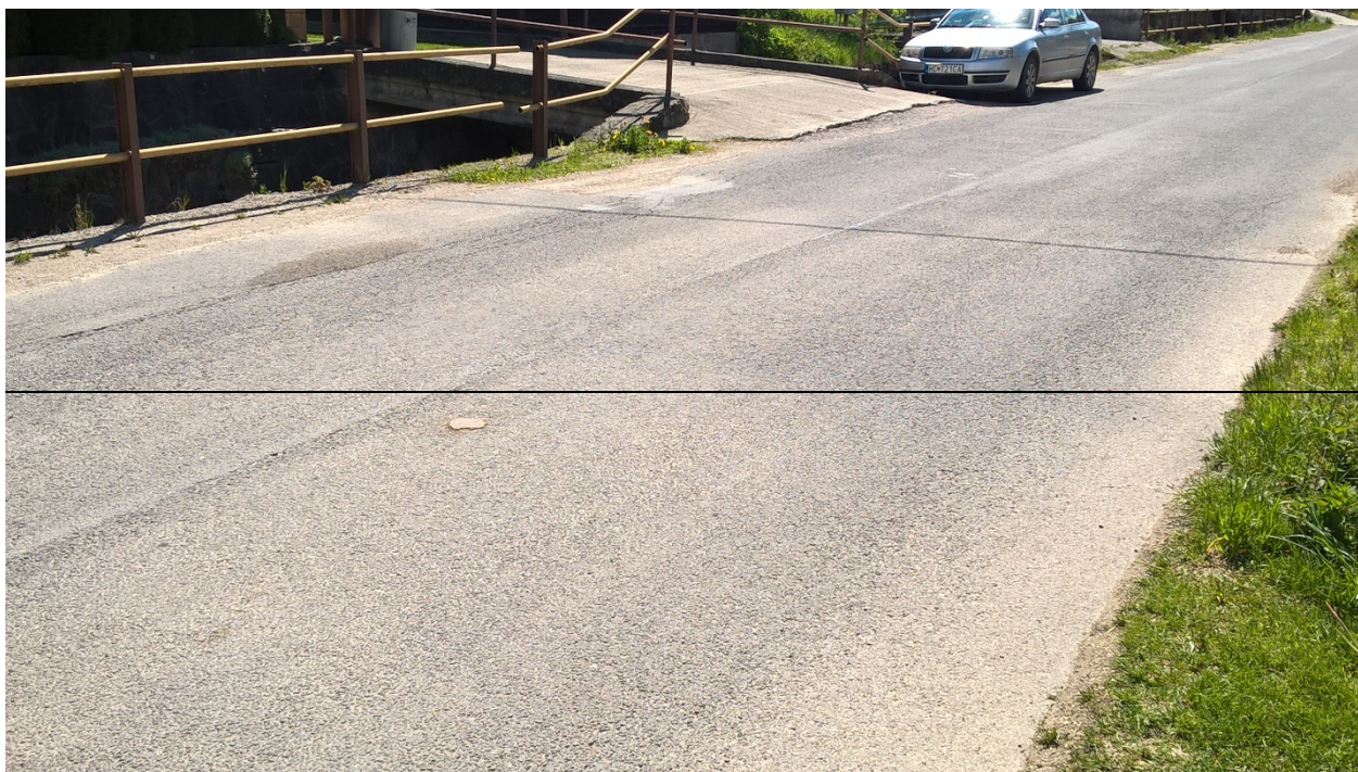
Obrusovanie povrchu vozovky
