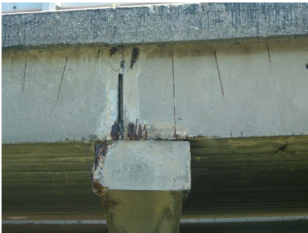
Nedostatočná úložná plocha
