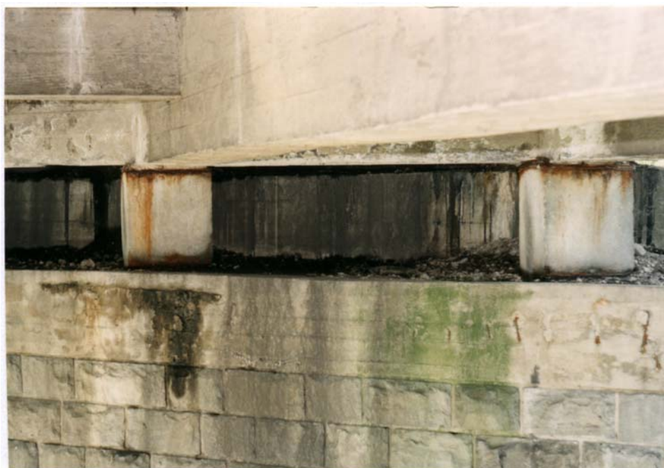
Vlhkosť a znečistenie v oblasti ložísk
