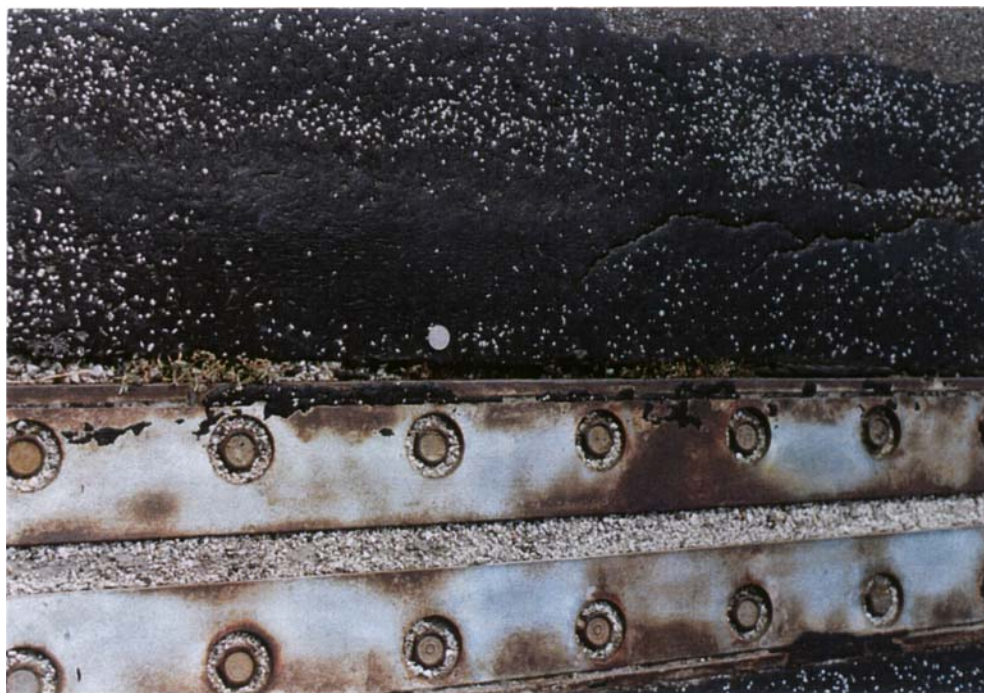
Znečistenie mostného záveru suťou
