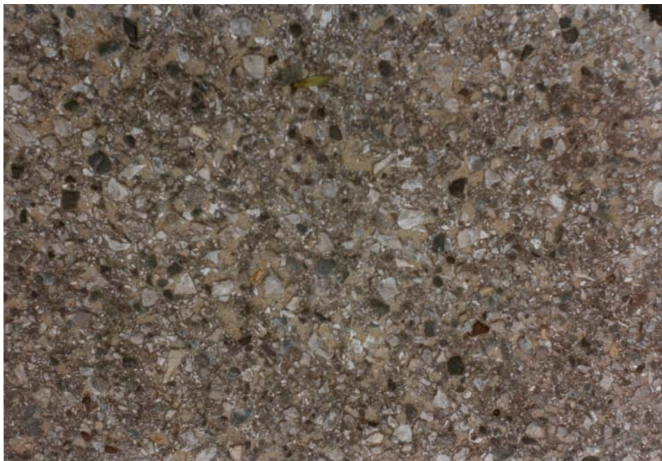
Vypieranie povrchu vozovky
