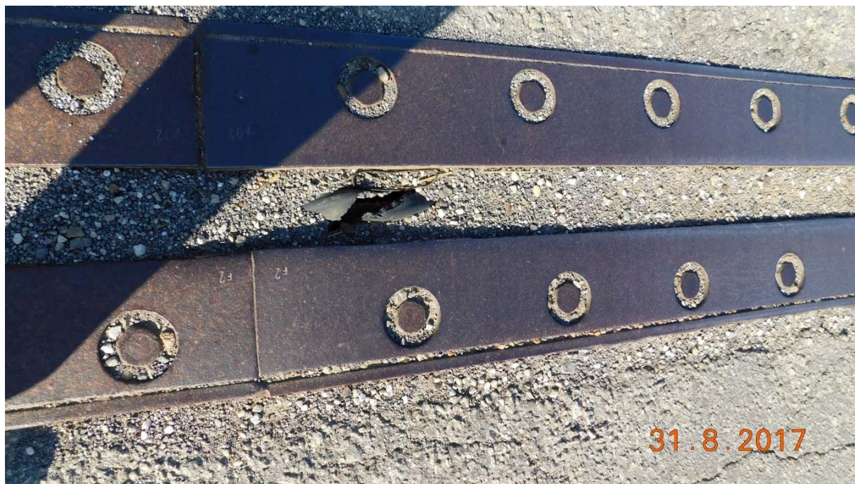
Chýbajúca gumová vložka dilatačného záveru
