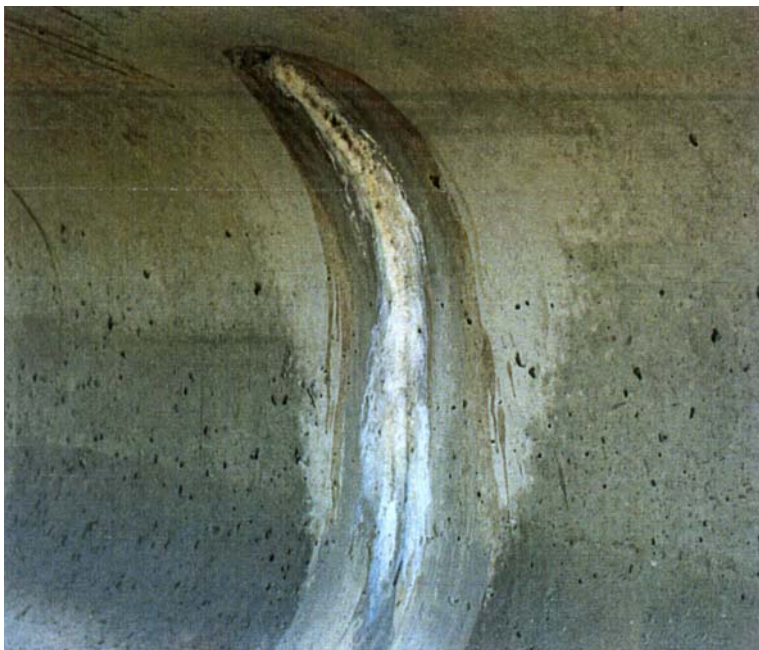
Inkrustácie na stene nosníka
