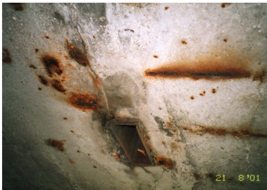
Krátka odvodňovacia rúrka
