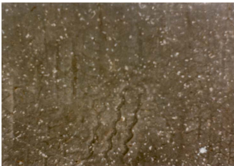
Potenie vozovky s odtlačenými pneumatikami
