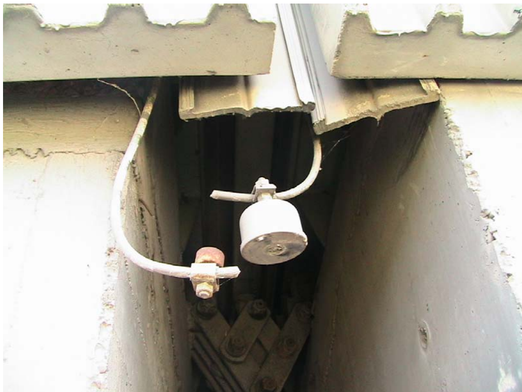
Poškodenie uzemnenia
