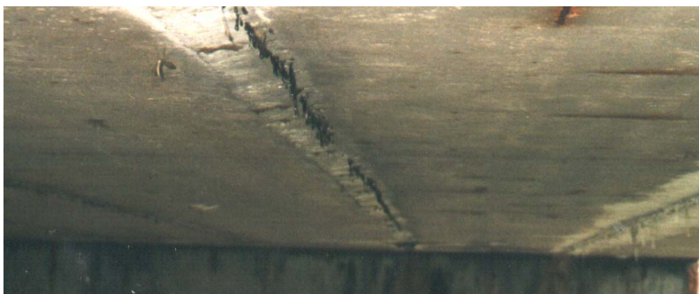
Roztopená hydroizolácia
