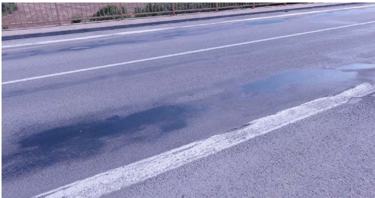
Vyhľadanie povrchu vozovky
