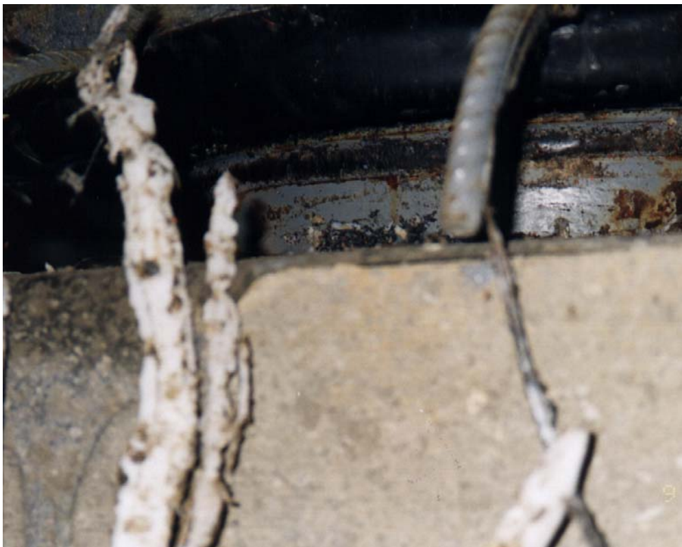
Ložisko s vytlačenými kusmi teflónovej vložky
