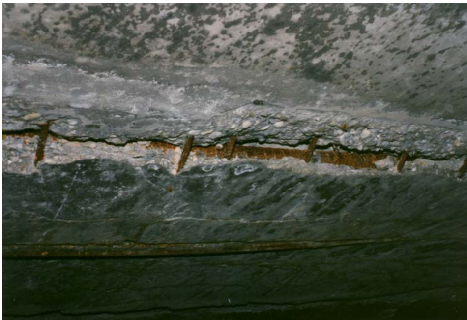
Obnažené rúrky káblových kanálikov
