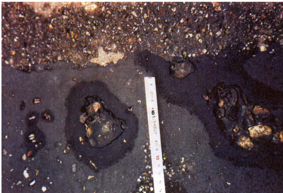
Odkrytie kameniva asfaltového mostného záveru
