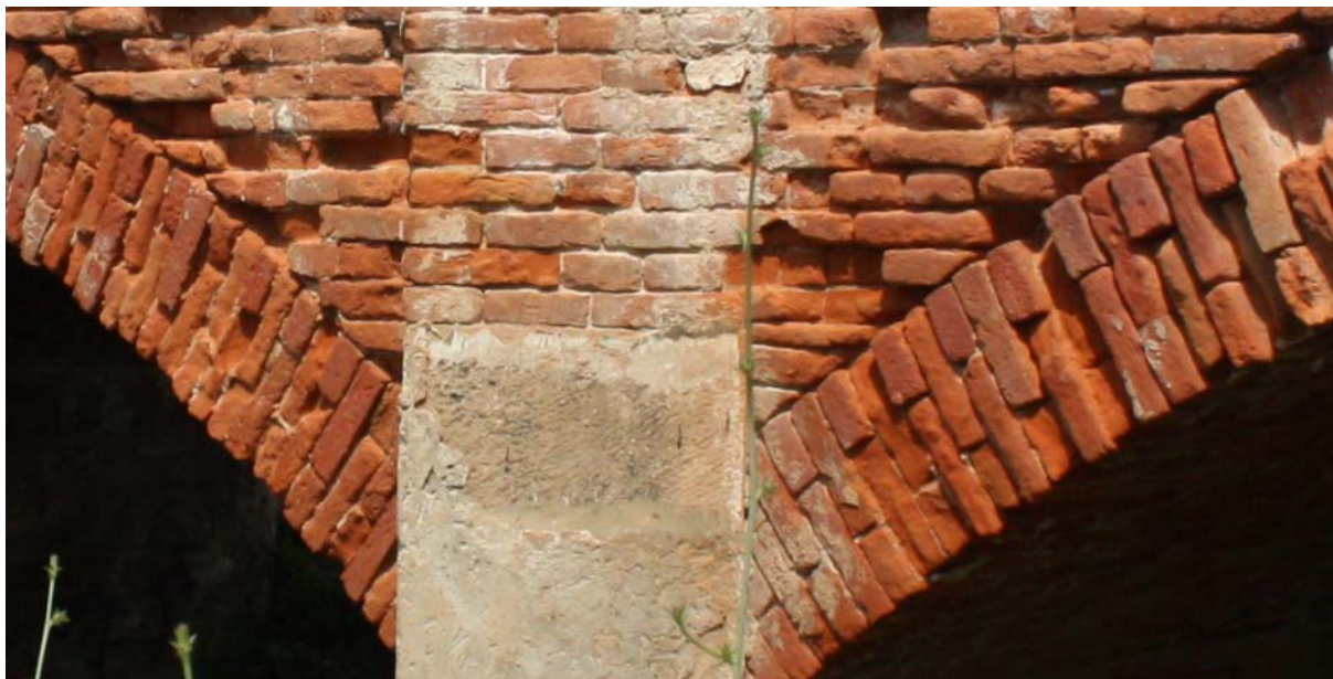
Rozpad murovacích prvkov
