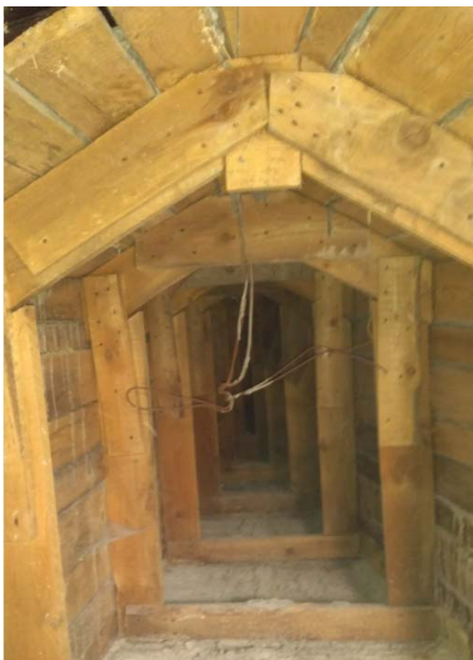
Neodstránené debnenie komory mosta
