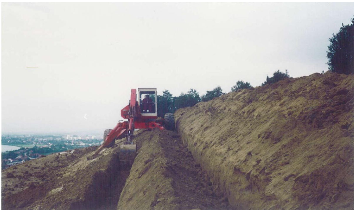
Hĺbenie rýh pre výsadbu na veľkom zárezovom svahu
