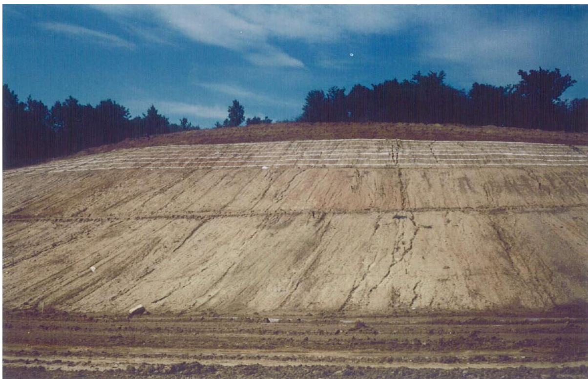
Zárezový svah pred vykonaním rýh a výsadbou s vyznačením umiestnenia drevín
