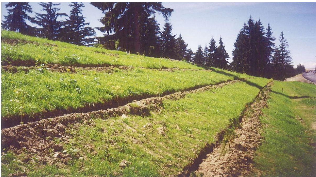
Výkop protieróznych rýh na zárezových svahoch pre realizáciu výsadiieb
