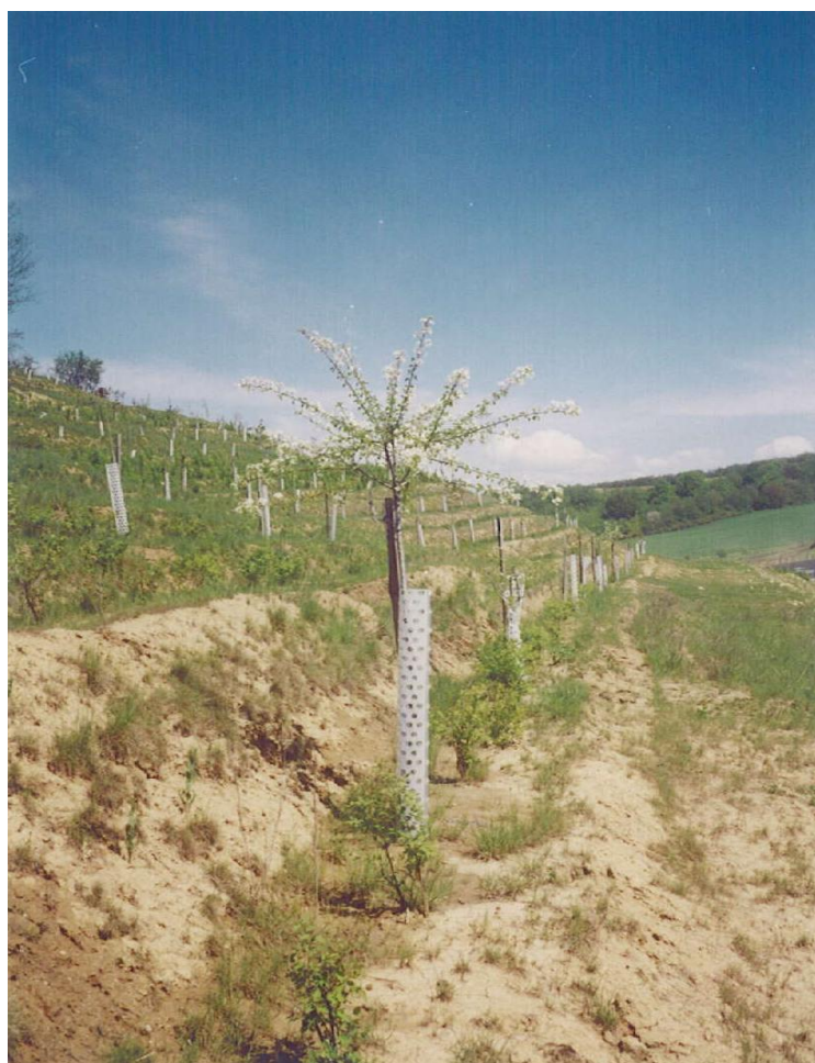
Výsadba stromov a kríkov na zárezovom svahu
