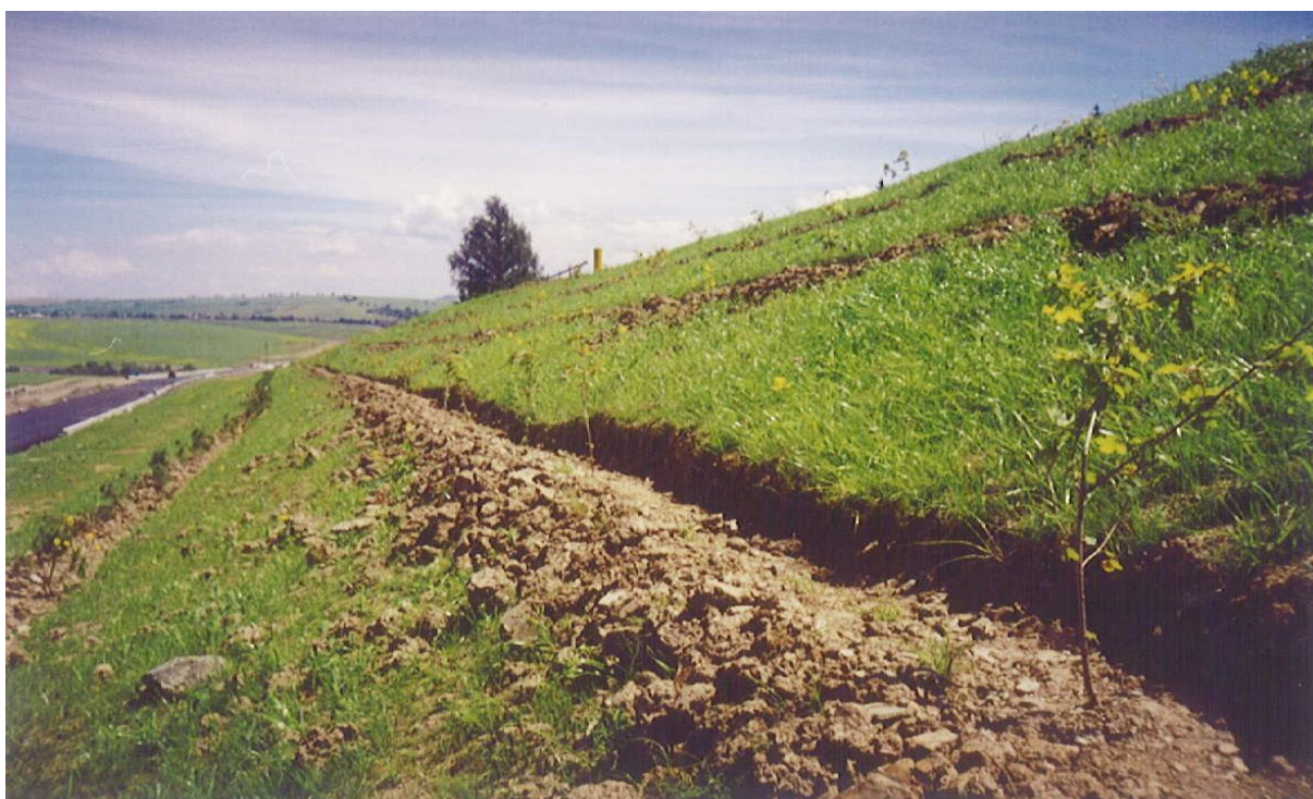
Výsadba v zárezovom svahu pri diaľnici D1 Ladce – Sverepec
