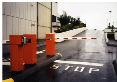
Obrázok 52 - Závara so sklopným ramenom
