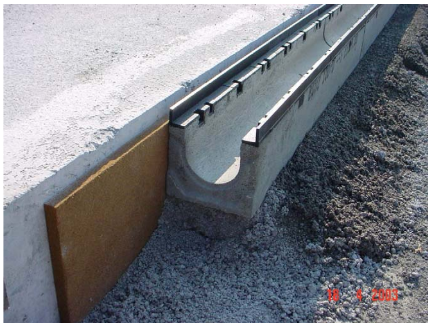
Obrázok 6 – Detail uloženia žľabu pri diaľnici
