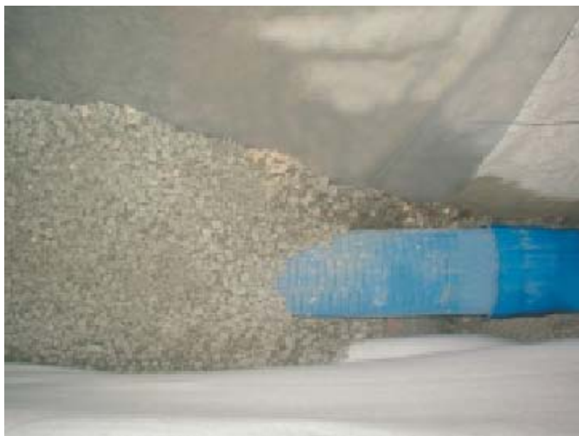
Obrázok 12 – Konštrukčné riešenie drenážneho systému-prísyp
