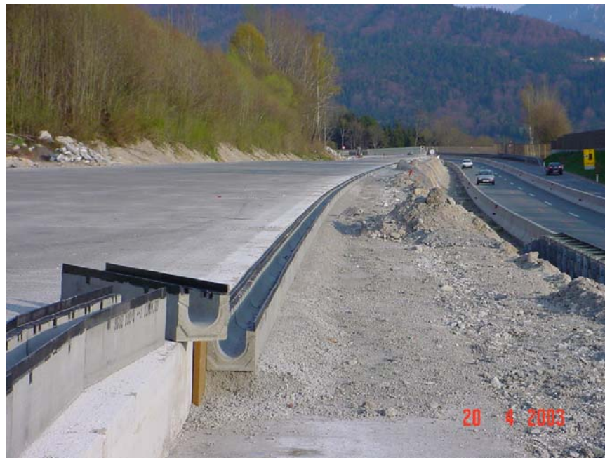
Obrázok 5 – Príklad uloženia žľabu pri diaľnici
