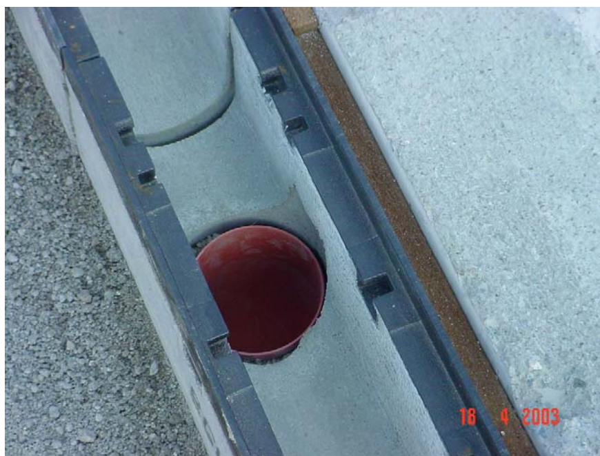
Obrázok 7 – Detail uloženia žľabového vpustu pri diaľnici
