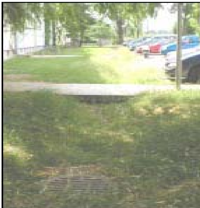
Obrázok 18 – Vsakovacia priekopa kombinovaná s núdzovým odvodnením
