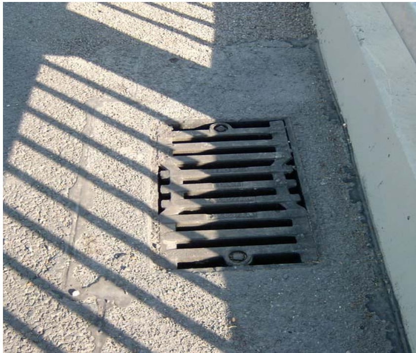
Obrázok 1 – Odvodňovač na mostnom objekte
