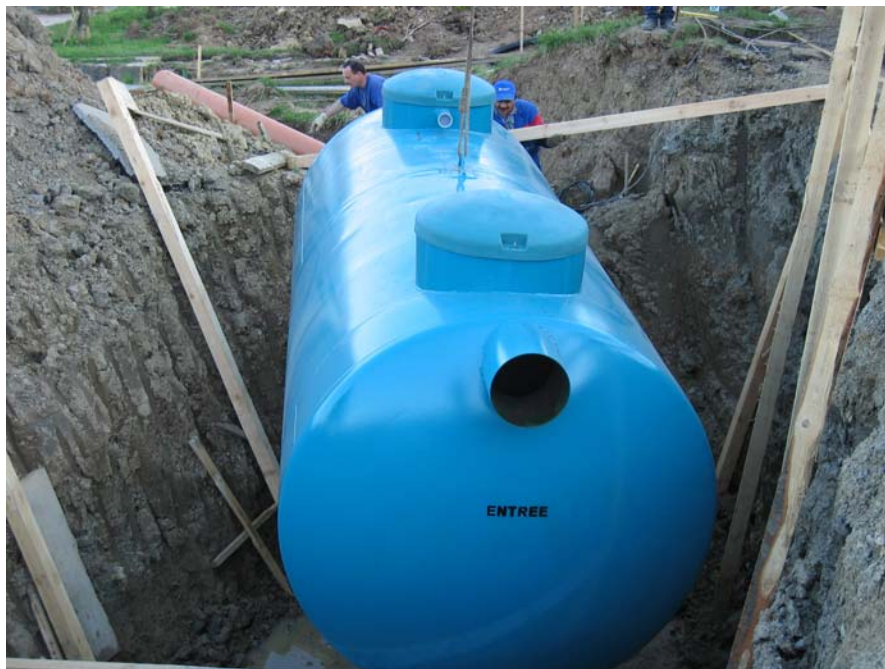
Obrázok 14 – Osadenie odlučovača do pripraveného priestoru
