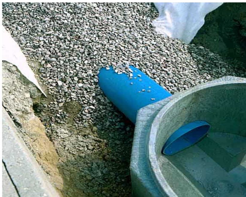
Obrázok 11 – Konštrukčné riešenie drenážneho systému-zaústenie
