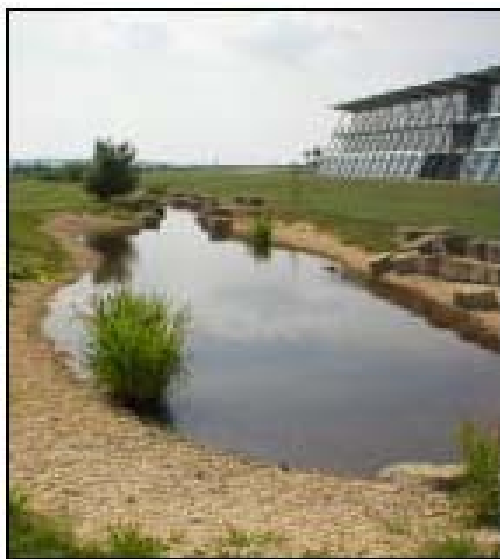
Obrázok 15 – Príklad vsakovacieho jazierka s trstinovým porastom na elimináciu znečistenia
