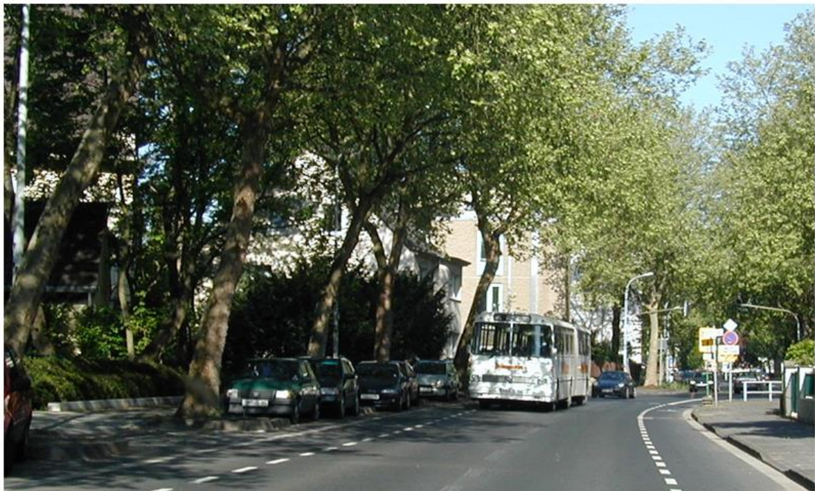
Obrázok 3.4.2 : Obojsmerné nadrozmerné pruhy Wesseling/D s paralelnými viacúčelovými pruhmi (foto: autor)
