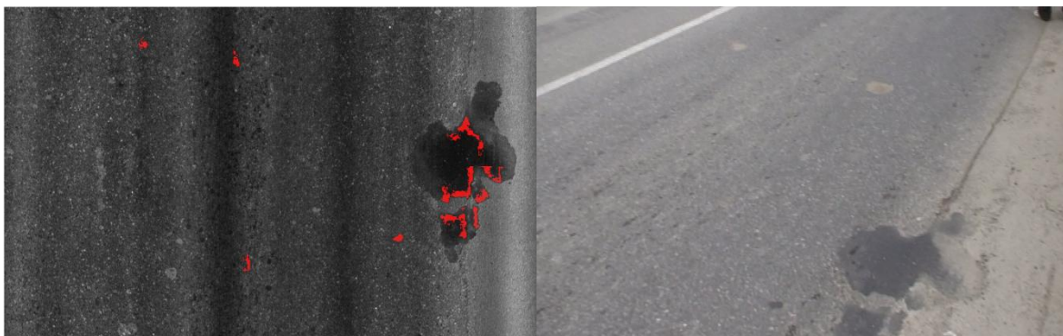
Obrázok 27 Oprava – LineScan versus videozáznam
