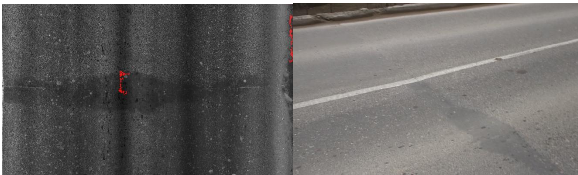
Obrázok 29 Priečna trhlina – LineScan versus videozáznam
