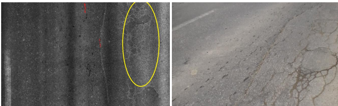
Obrázok 28 Siet'ové trhliny – LineScan versus videozáznam
