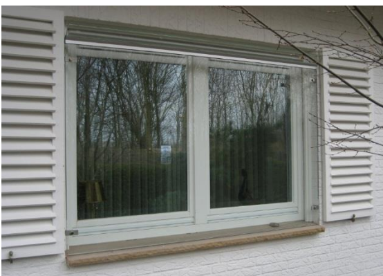
Obrázok 3 Príklady realizácií predsadeného jednoduchého zasklenia, zdroj [39], [40], [39], [41], [42], [39], [39], [39]
