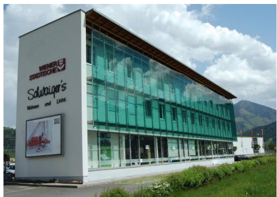
Obrázok 3 Príklady realizácií predsadeného jednoduchého zasklenia, zdroj [39], [40], [39], [41], [42], [39], [39], [39]
