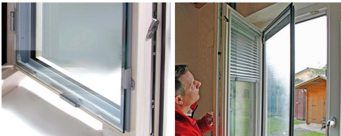
Obrázok 7 Detaily okenných konštrukcií s dodatočným prídavným zasklením [53]
