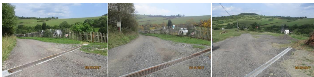
Obrázok 43 – Pohľady na vozovku so zabudovanými starými zvodičmi MK2 v Pekline v deň pokládky R-materiálu 25.8.2017 a 19.10.2017
