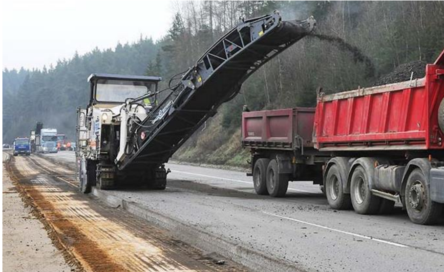
Obrázok 2 – Frézovanie konštrukcie vozovky
