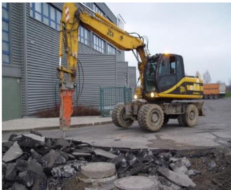
Obrázok 3 – Búranie konštrukcie vozovky vo forme kusov, kryh
