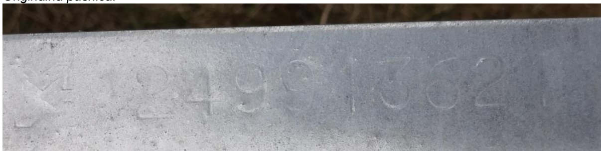
Obrázok 33 – Identifikačné znaky vyrazené na zvodnici - 1249913621
