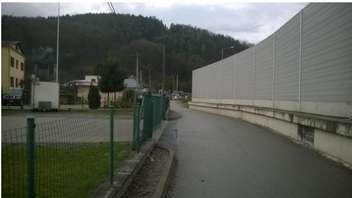
Obrázok 6.4 Protihluková stena a monitorovacie stanovište v areáli firmy TECHPLASTY s.r.o., MMSKO ENV
