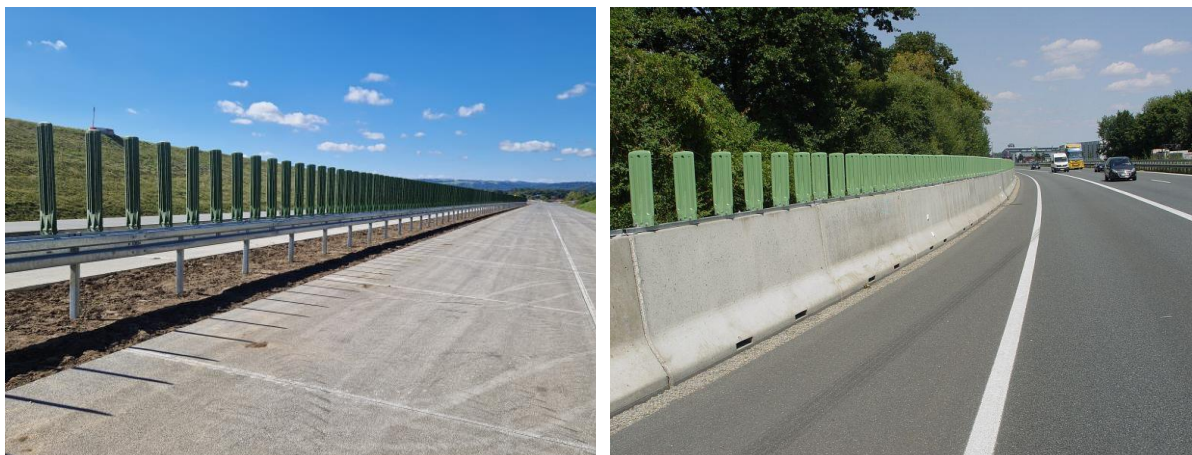
Obrázok 1 – protioslnivé clony inštalované na oceľových a betónových zvodidlách
