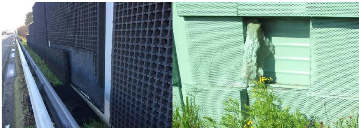
Obrázok 7 - Príklady pádu absorpčného materiálu
