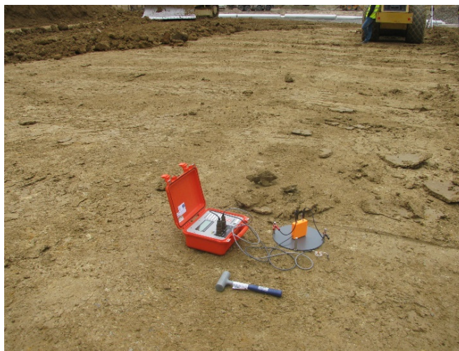
Obrázok 24 - Určovanie objemovej hmotnosti a vlhkosti zeminy elektronickým hutnomerom Humboldt H-4114C, Vodná nádrž L'adovo, Lučenec
