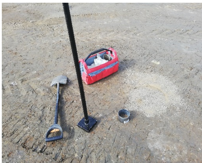
Obrázok 23 - Určovanie objemovej hmotnosti zeminy metódou vyrezávacieho valca na stavbe Vodná nádrž Ľadovo, Lučenec
