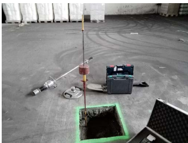
Obrázok 26 - Použitie ľahkého dynamického penetrometra na overenie vlastností podlažia priemyselnej podlahy v kombinácii s ľahkou dynamickou doskou pri stavebno-technickom prieskume konštrukcie
