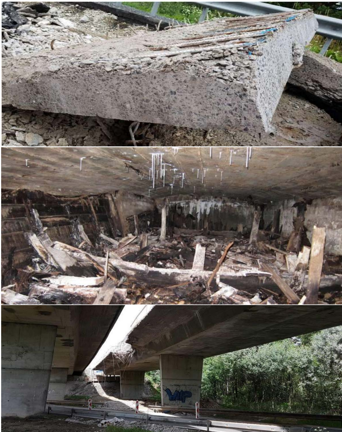
Obrázok 6 [L71, L72] – Fotodokumentácia diagnostiky mostného objektu D1-299 Podbanské Na danom mostnom objekte došlo v zmysle [L71, L72] ku kombinácii výskytu AKR v betóne hornej stavby mosta, čo spolu s nedostatočnými opatreniami počas zimnej betonáže, spôsobilo rozpad štruktúry betónu v rozsahu, ktorý spôsobil zaradenie mosta do stavebno-technického stavu VII.- havarijný stav.
