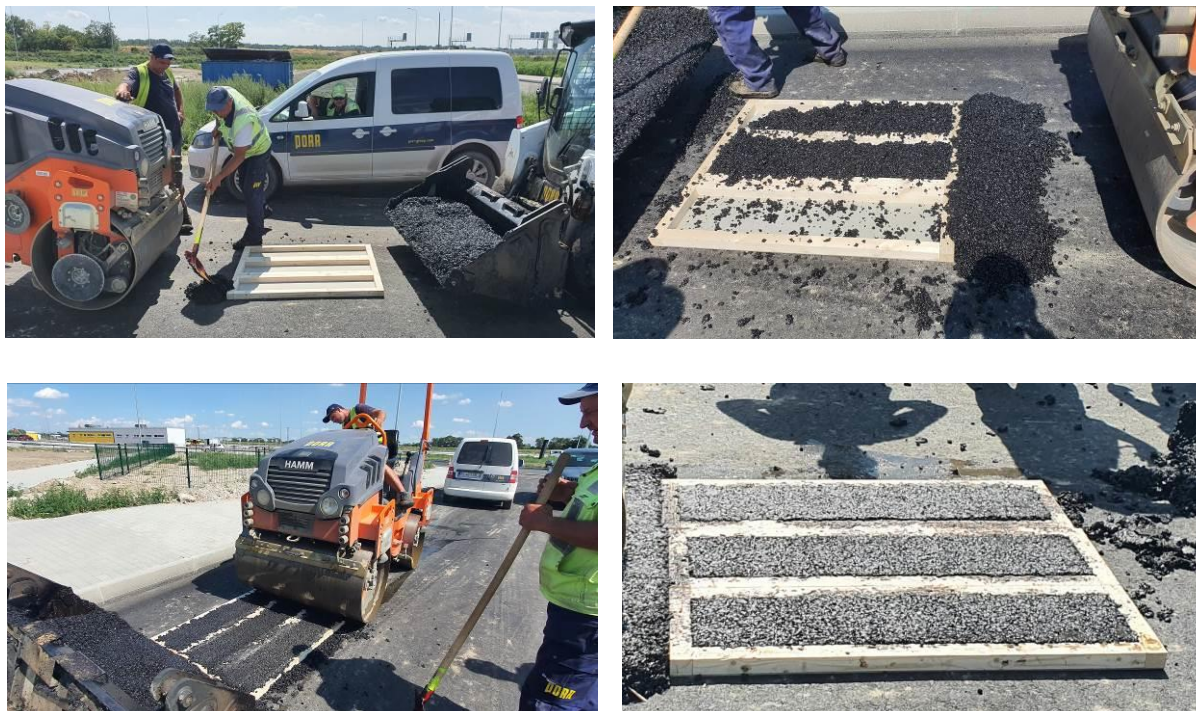
Obrázok 5 – 8 Príprava vzoriek na skúšky asfaltovej zmesi SMA 11 O PMB 45/80-75
