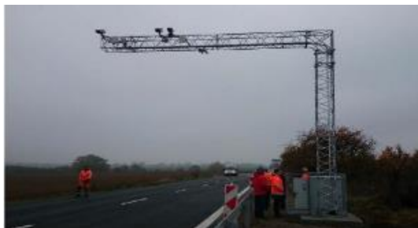
Obrázok 3 - Ukážka brány s predselektívnym systémom
