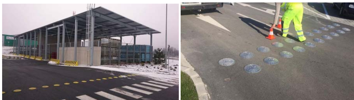
Obrázok 4 - Príklad osádzania spomaľovacích retardérov, Lidl Prešov-Záborské (vľavo), Amazon Sereď (vpravo)
