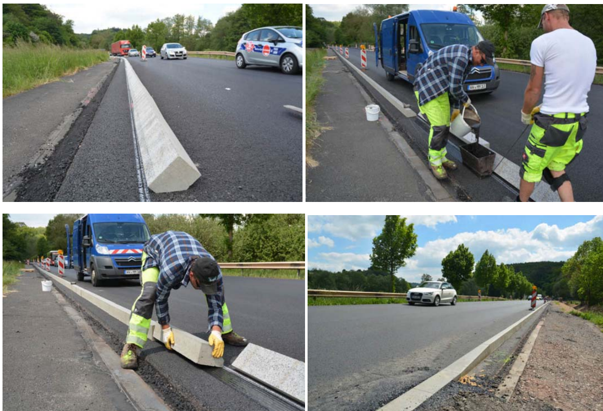
Obrázok 3 – Ukážka osádzania obrubníkov na báze lepidiel na ceste B54, zdroj: ( https://www.submission.de/news.php/Schneller-fertig-dank-Bordstein-Klebetchnik.html )
