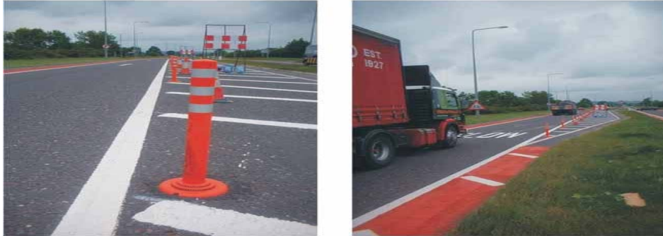
Obrázok 7 – Príklady osádzania deliacich stĺpikov technológiou na báze lepidiel
