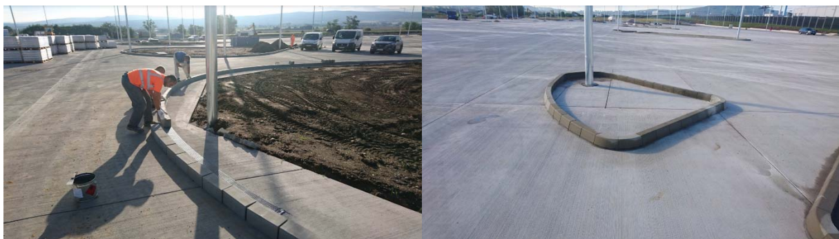
Obrázok 2 - Aplikácia technológie lepených obrubníkov v areáli firmy Volkswagen v Bratislave v roku 2017
