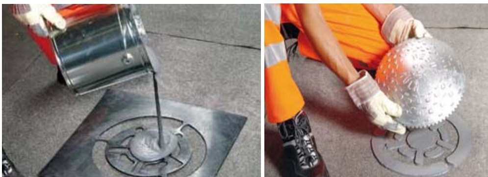
Obrázok 15 – Osádzanie tanierov a vytváranie spomaľovacích retardérov
