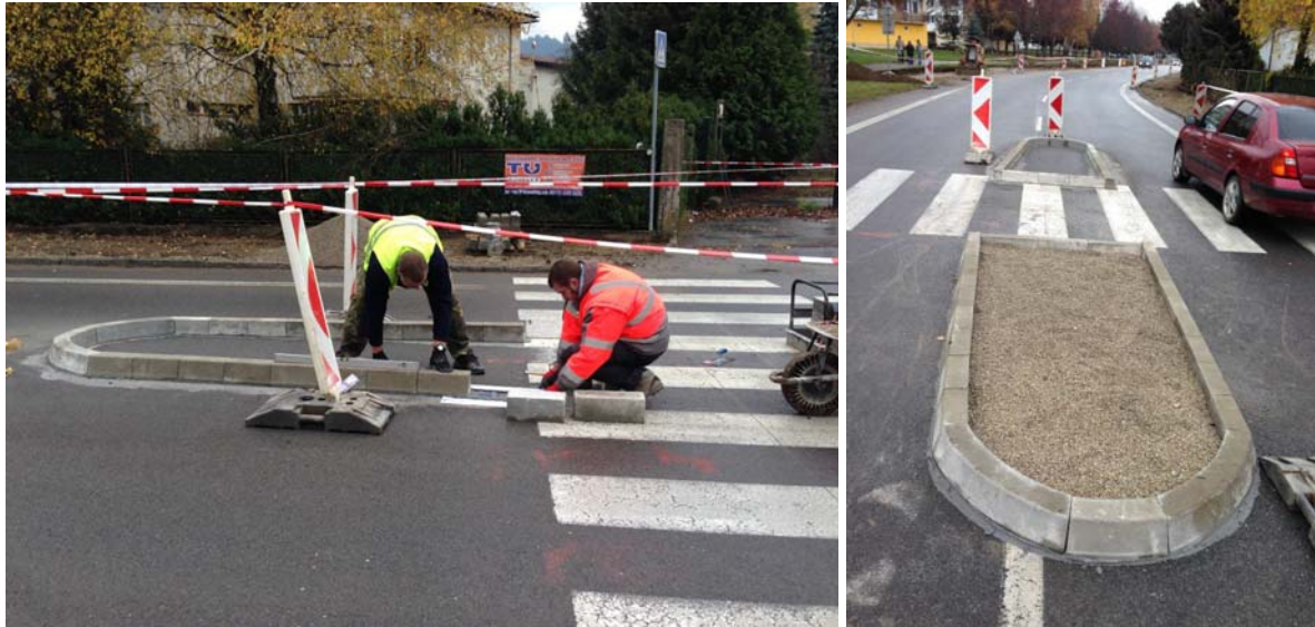
Obrázok 1 - Realizácia cestných ostrovčekov a referenčného úseku v meste Bytča v roku 2013
