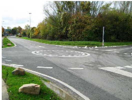
Obrázok 5 – Realizácia okružných križovatiek pomocou hliníkových tanierov technológiou na báze lepidiel v meste Düren
