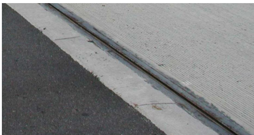
Obr. 30 a,b,c : Záver s elastomerovým profilovaným tesnením
