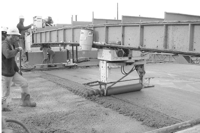
Obr. 39: Detail vibrovania a hladenia betónu
