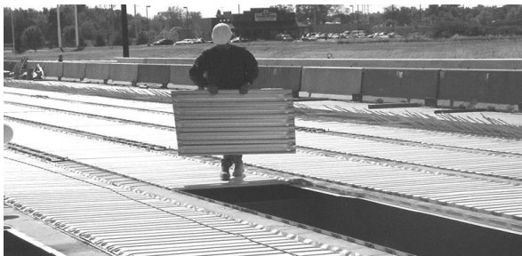
Obr. 34: Kovové panely strateného debnenia
