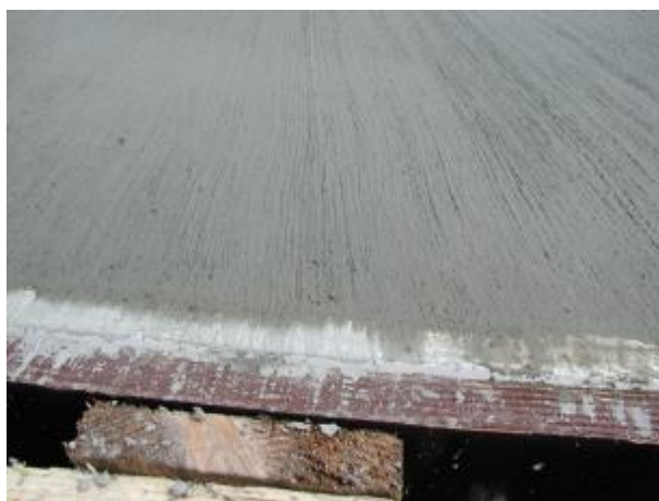
Obr. 79: Finálna úprava povrchu priečnou striážou
