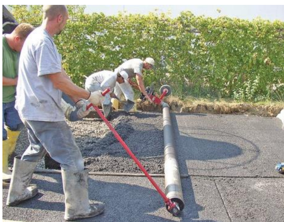
Obr. 41: Ručný mechanický valec
