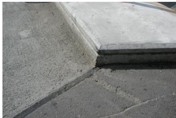
Obr. 67: CB kryt mosta - prechodová oblasť
