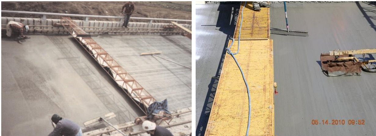
Obr. 49, 50: Vykonávanie finálnej textúry povrchu drôteným tiahom, vľavo na betónovom kryte s kremičitými prísadami, vpravo na mostovke tesne za hladiacim zariadením
