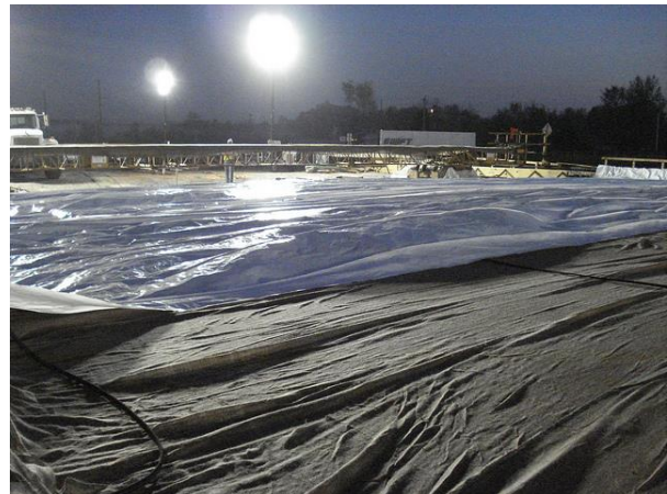
Obr. 51, 52: Vľavo rozprašovanie vody na upravený povrch, vpravo prikryvanie zvädnutého betónu jutou a fóliami
