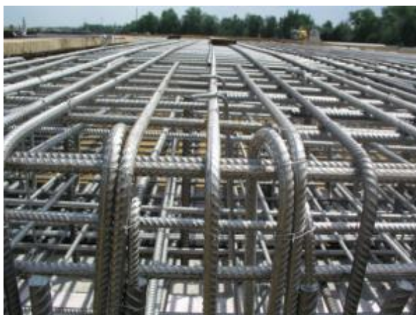
Obr. 74: Nerezová výstuž
