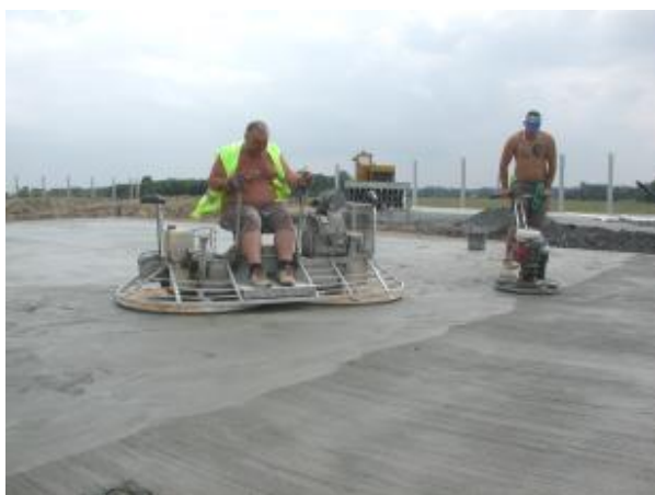
Obr. 78: Úprava povrchu mostovky leštením
