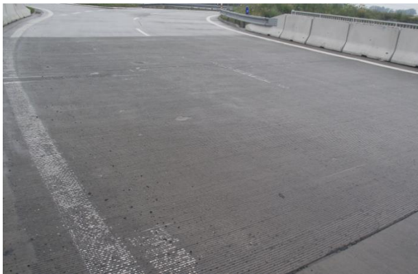
Obr. 80: Povrch mostovky po frézovaní
