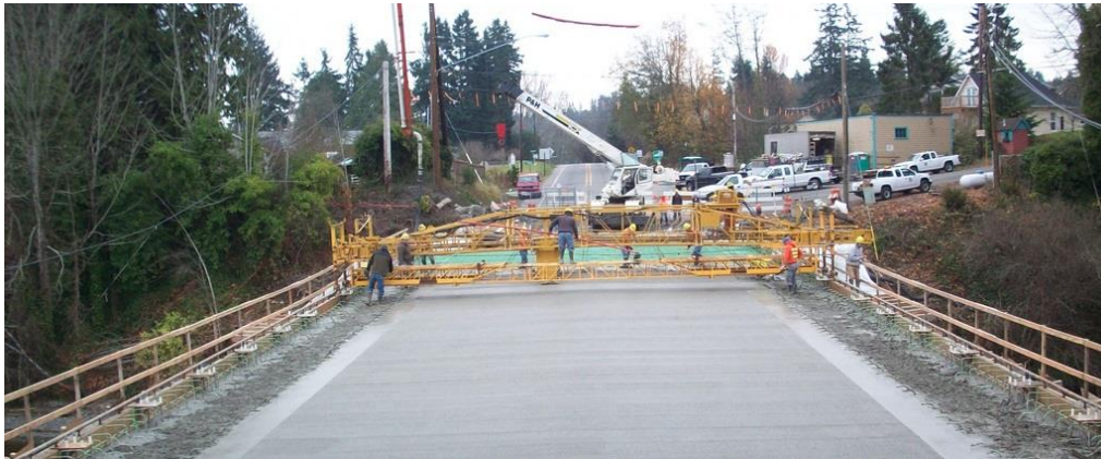
Obr. 48: Pozdĺžny pojazd sťahovacieho zariadenia, pozdĺžne hladiace zariadenia pohybujúce sa priečne
