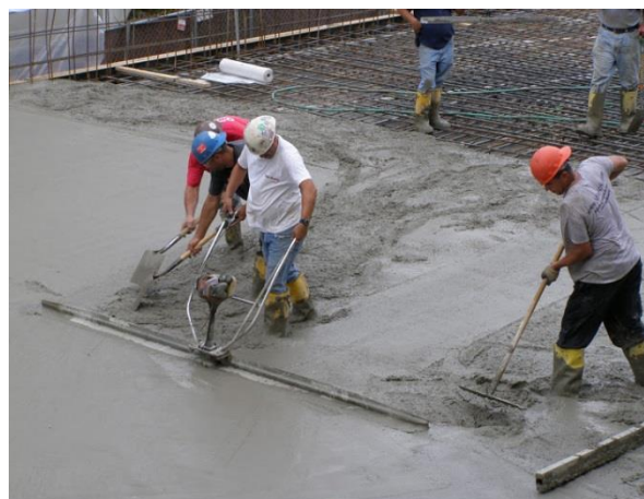
Obr. 42: Ručná vibračná lišta
