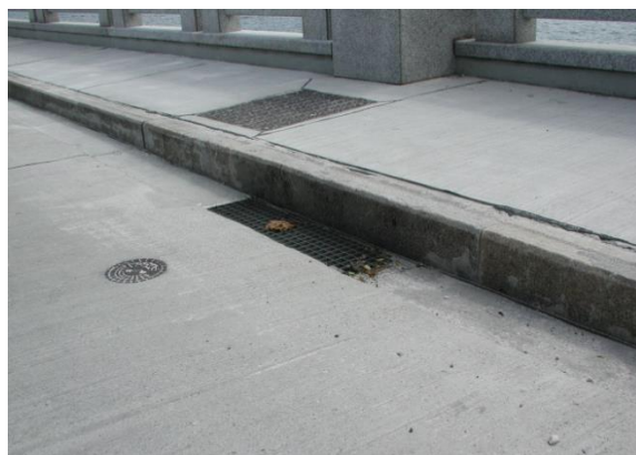
Obr. 57: Začiatok mosta nad bezpečnostným prelivom
