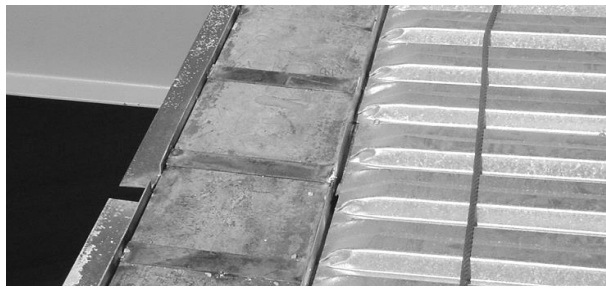
Obr. 35: Uloženie kovových panelov strateného debnenia
