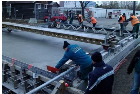
Obr. 85: Betonáž mostovky
