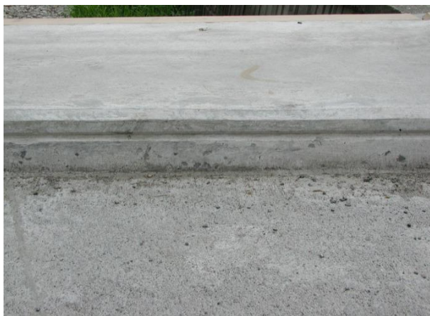
Obr. 68: Povrchová úprava - rímsa, CB kryt
