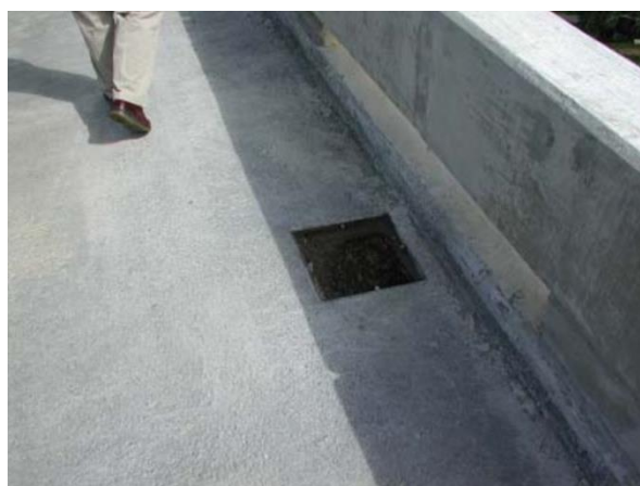
Obr. 23: Široký odvodňovač s prídavnou výstužou dosky
