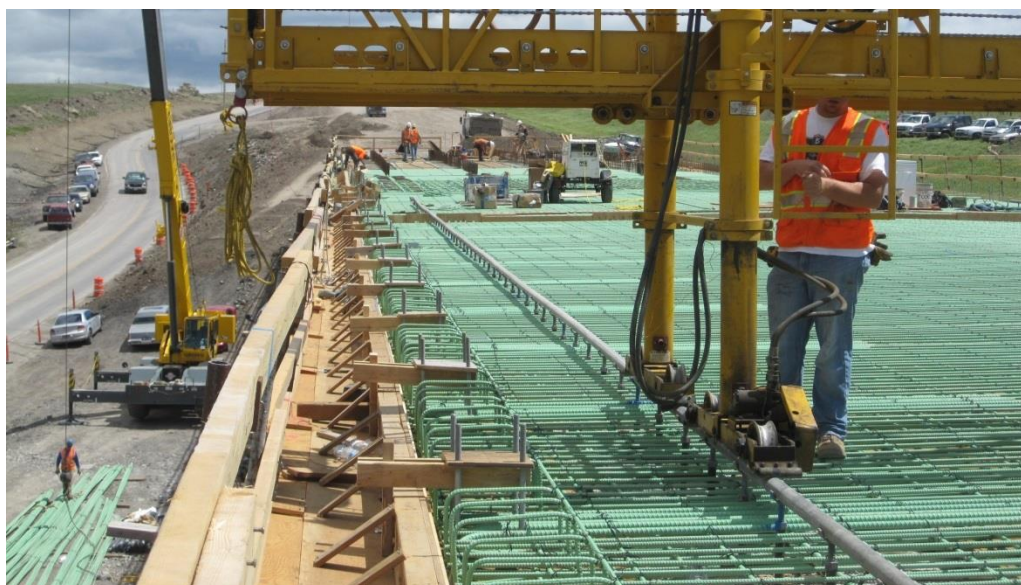
Obr. 47: Skúšobný pojazd mechanického sťahovacieho zariadenia, kontrola správneho výškového nastavenia vodiacej tyče pre správny sklon povrchu a zaistenie požadovaného
