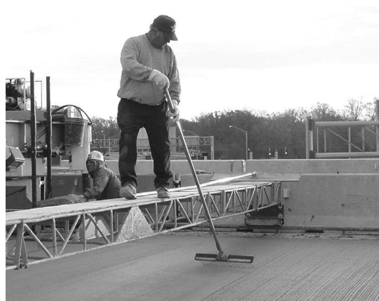
Obr. 40: Vytváranie priečnej textúry kefou
