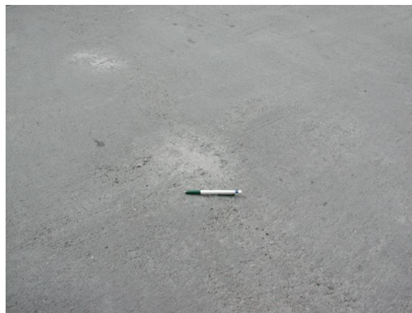
Obr. 69: Lokálna nejednotnosť povrchu
