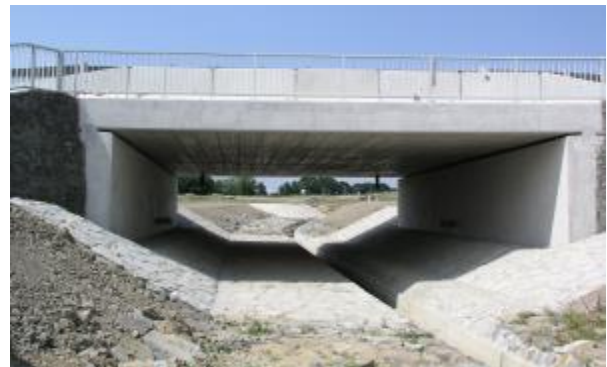
Obr. 73: Priamo pojazdný most SO 237 po uvedení do prevádzky
