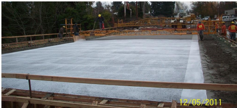
Obr. 53: Aplikácia parotesnej ochrannej vrstvy
