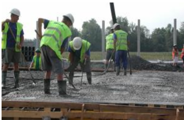
Obr. 76: Ukladanie betónu a hutnenie
