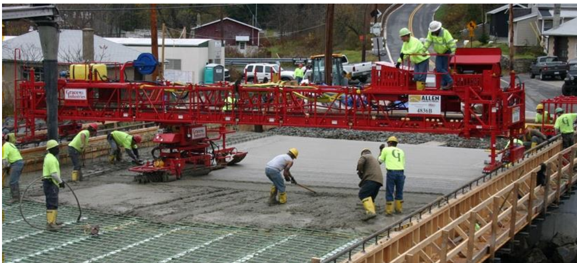
Obr. 38: Príklad mostného finišera
