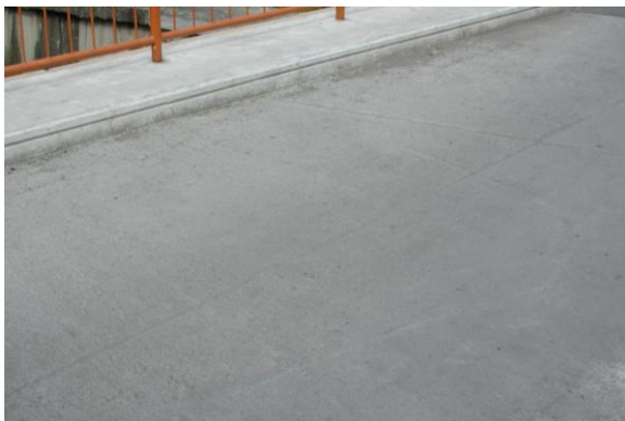
Obr. 66: Prerezané škáry v CB kryte
