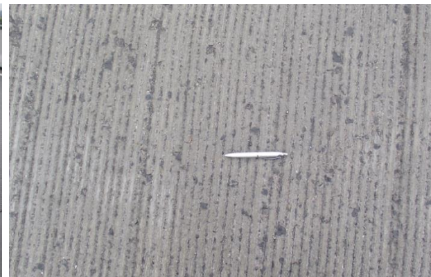
Obr. 81: Detail povrchu mostovky po frézovaní
