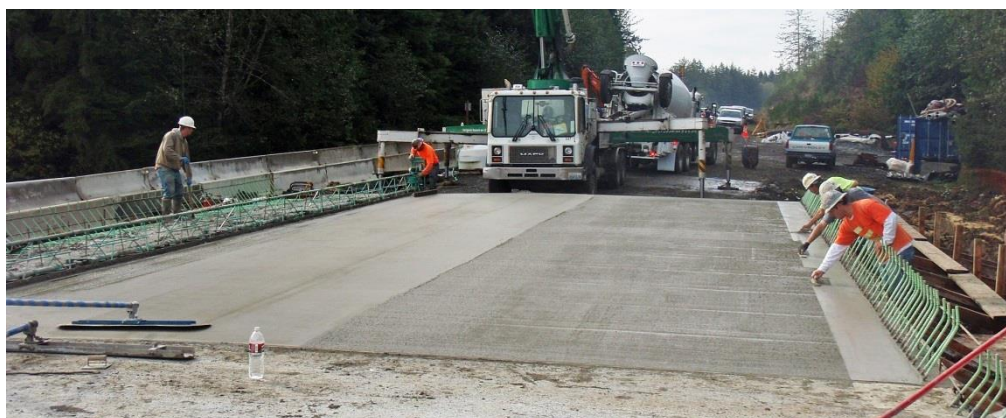
Obr. 46: Priečny pojazd sťahovacieho zariadenia, pozdĺžne hladenie, priečna striáž povrchu
