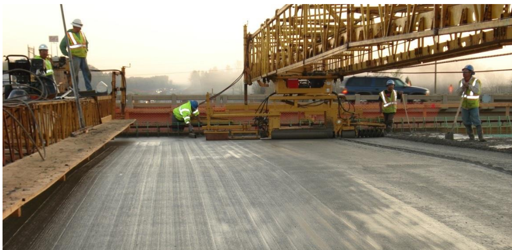
Obr. 43,44,45: Pozdĺžny pojazd sťahovacieho zariadenia, pozdĺžne hladiace zariadenie pohybujúce sa priečne
