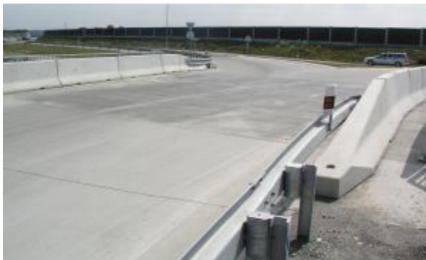
Obr. 72: Priamo pojazdný most SO 236 po uvedení do prevádzky
