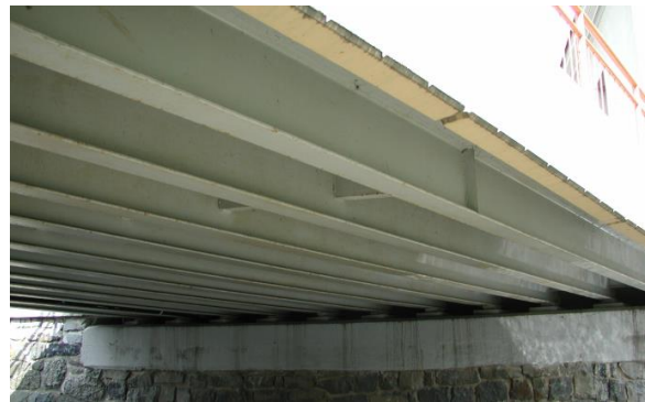
Obr. 65: Podhľad nosnej konštrukcie
