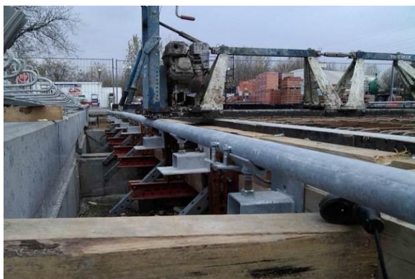
Obr. 84: Prvky pre presné vedenie vibračnej lišty
