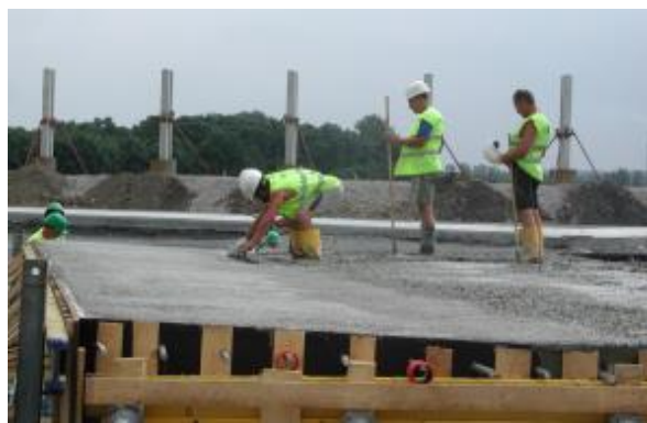
Obr. 77: Rovnanie povrchu do požadovaného sklonu
