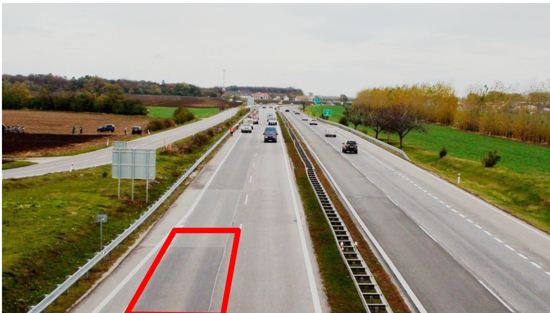
Obr.1: Celkový pohľad na vozovku rýchlostnej komunikácie R1 s vyznačením približného rozsahu časti s nestmelenou podkladovou vrstvou
