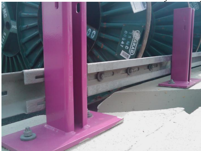
Obr. 43 Kvalitné zhotovenie nástreku horizontálnej izolačnej pásnice
