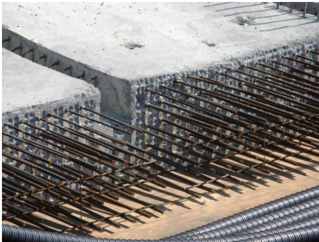
Obr. 15 Krytie výstuže 50 mm je štandardom
