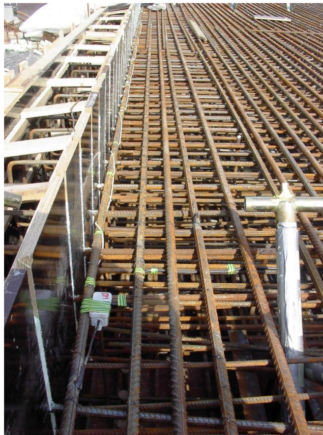
Obr. 38 Príklad aplikácie systému CMS na nosnej konštrukcii mostnej stavby
