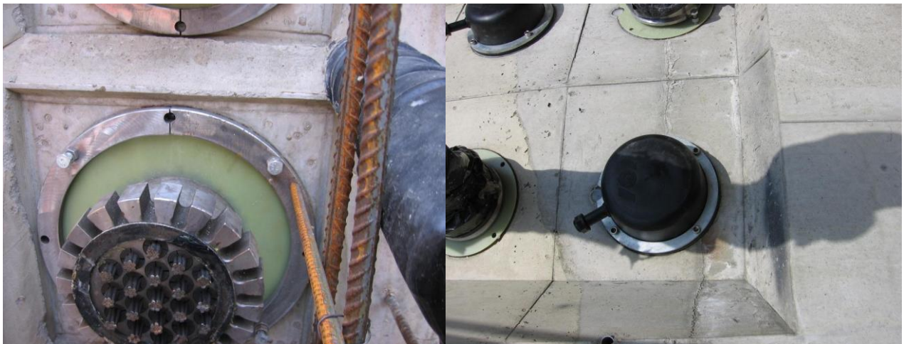
Obr. 29 Systém predpätia s elektricky izolačnými rúrami a ochranou hláv káblov
