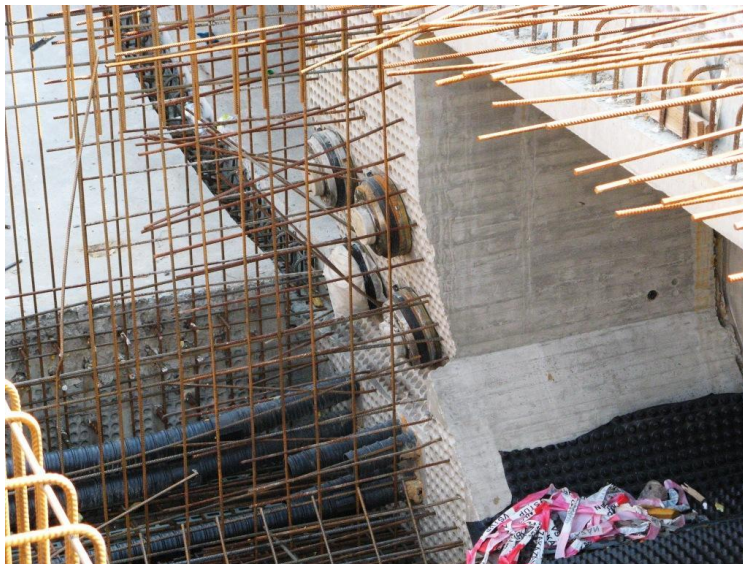
Obr. 29 Systém predpätia s elektricky izolačnými rúrami a ochranou hláv káblov
