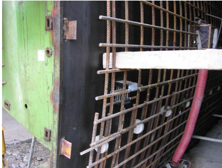
Obr. 40 Príklad použitia sondy CPMP na systéme predpätia v nosnej konštrukcii mostnej stavby
