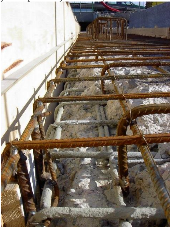
Obr. 19 Správne vykonanie prevarenia výstuže pomocnými bodovým zvarmi
