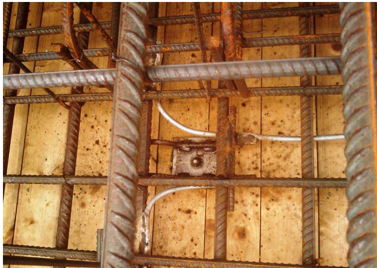
Obr. 24 Aplikácia typizovaného vývodu (C.R.M.) z prevarovanej výstuže pre hornú časť. Doska sa uloží na dno debnenia a fixuje sa jednak prevarením, jednak prichytením do debnenia.
