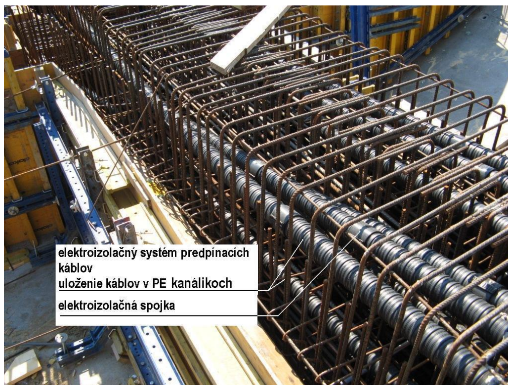
Obr. 12 Príklad elektricky izolovaného predpätia v železobetónovej konštrukcii
