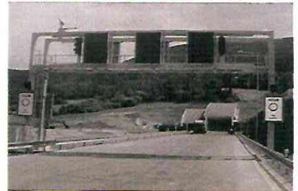
obr. 10 Úsek diaľnice D1 Beharovce–Široké s prvým diaľničným tunelom Branisko [8]
