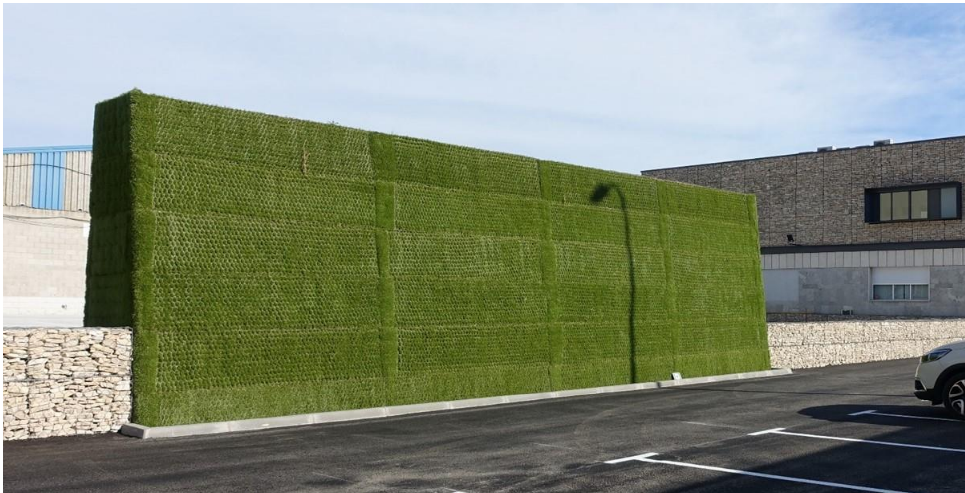
SonicMAC GNB (Green Noise Barrier) Protihluková bariéra vyrobená z GREEN-TERRAMESH® blokov spol. MACCAFERRI pre environmentálne riešenia protihlukových bariér
