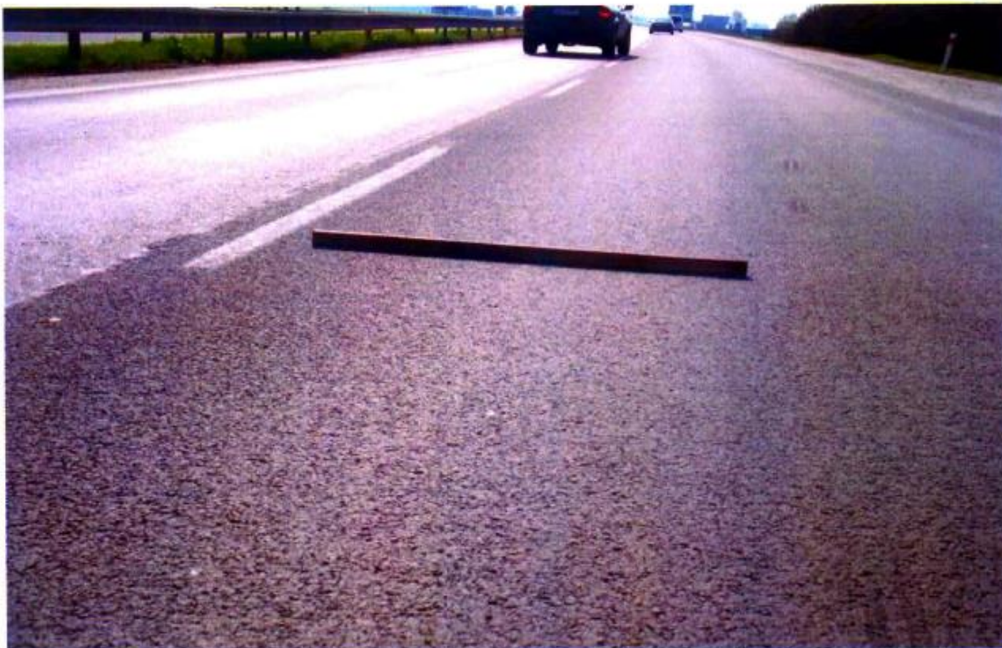
Obrázok č.2 Opravovaný jazdný pruh bez koľaje
