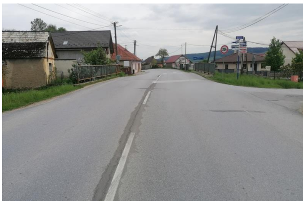
Začiatok úseku NL v smere staničenia
