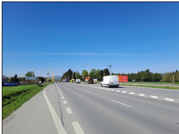
Začiatok úseku NL v smere staničenia
