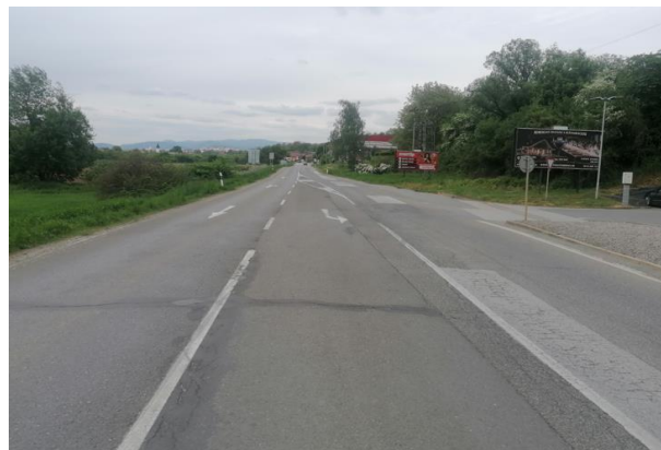
Koniec úseku NL proti smeru staničenia
