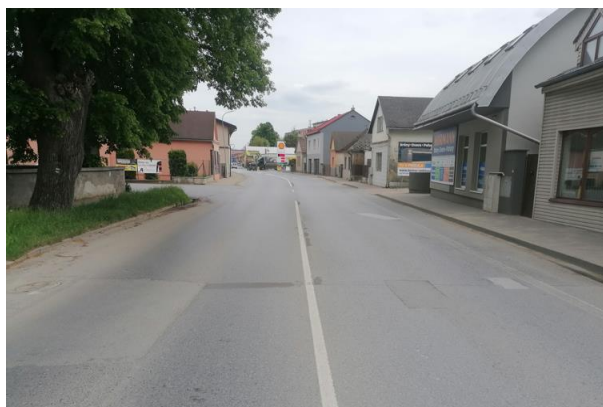
Začiatok úseku NL v smere staničenia
