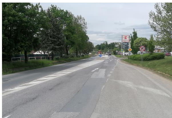
Koniec úseku NL proti smeru staničenia
