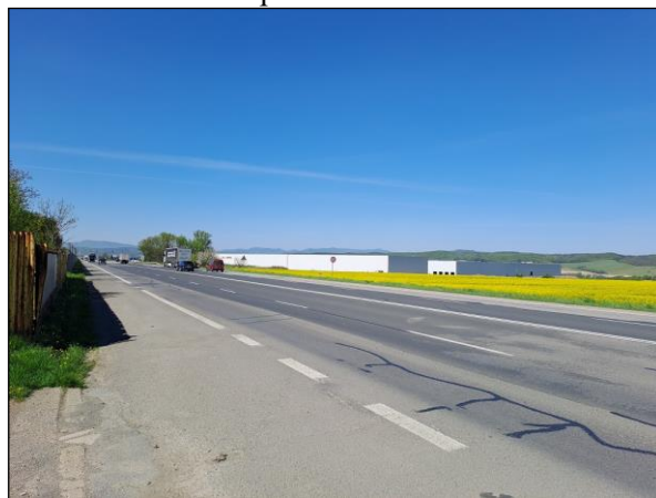
Koniec úseku NL proti smeru staničenia
