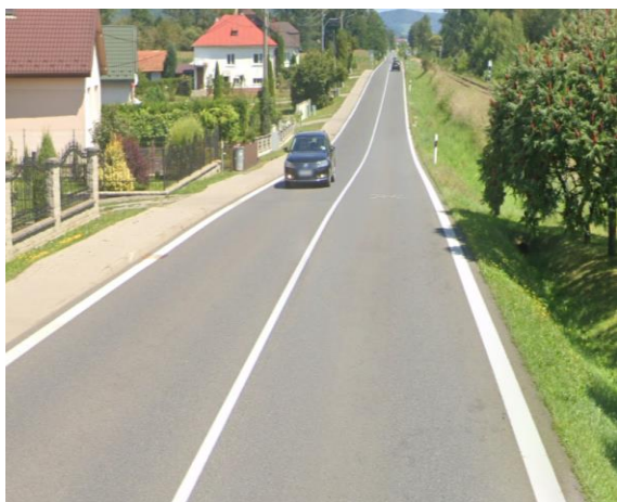
Začiatok úseku NL v smere staničenia
