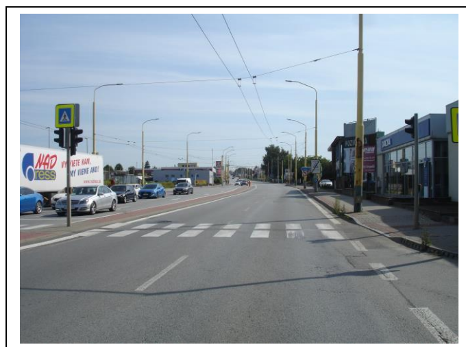
Koniec úseku NL proti smeru staničenia
