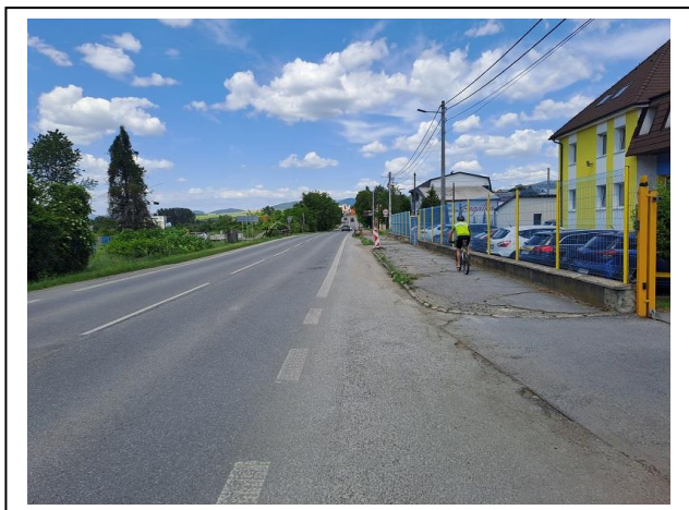
Začiatok úseku NL v smere staničenia
