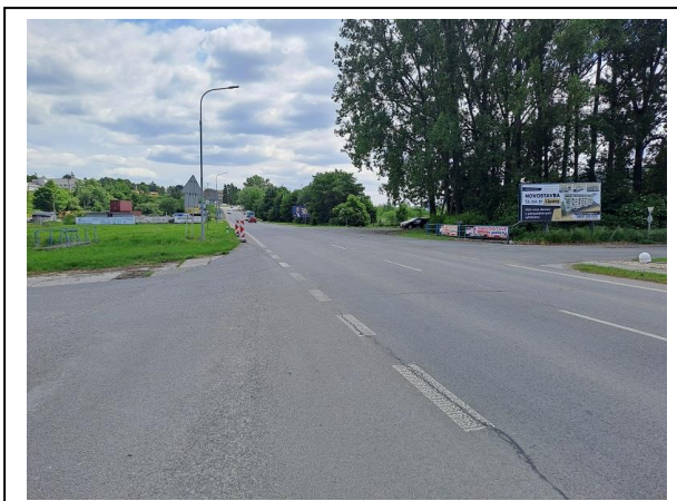
Koniec úseku NL proti smeru staničenia
