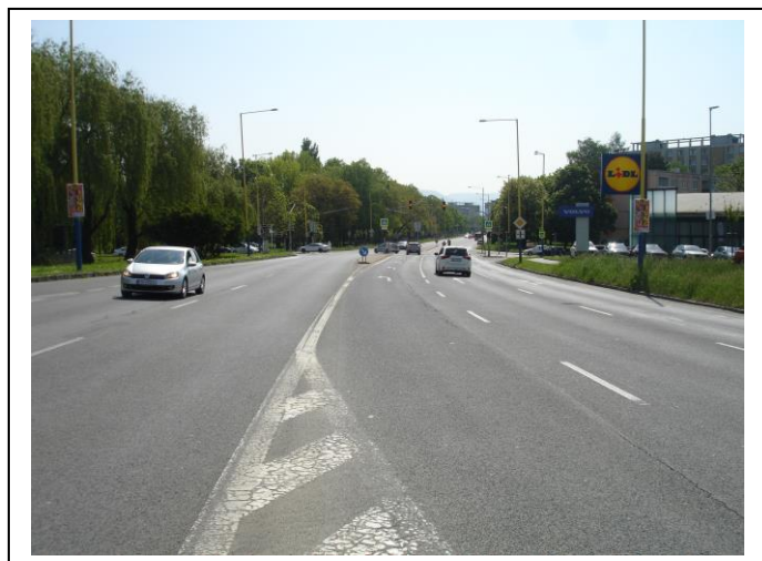
Začiatok úseku NL v smere staničenia
