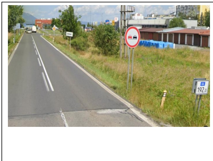
Začiatok úseku NL v smere staničenia
