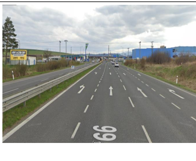
Koniec úseku NL proti smeru staničenia
