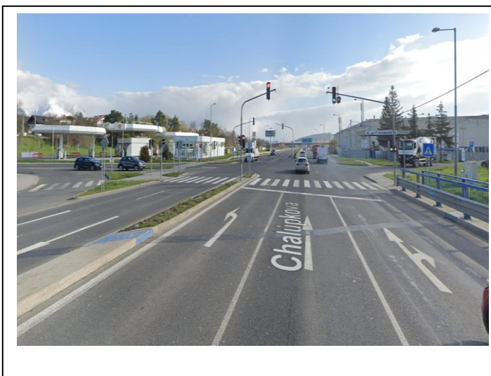
Začiatok úseku NL v smere staničenia
