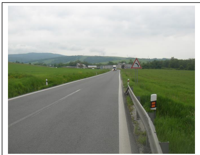
Začiatok úseku NL – v smere staničenia
