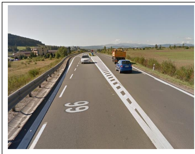
Koniec úseku NL proti smeru staničenia
