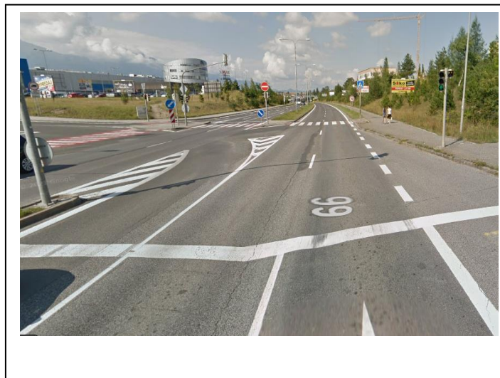
Začiatok úseku NL v smere staničenia
