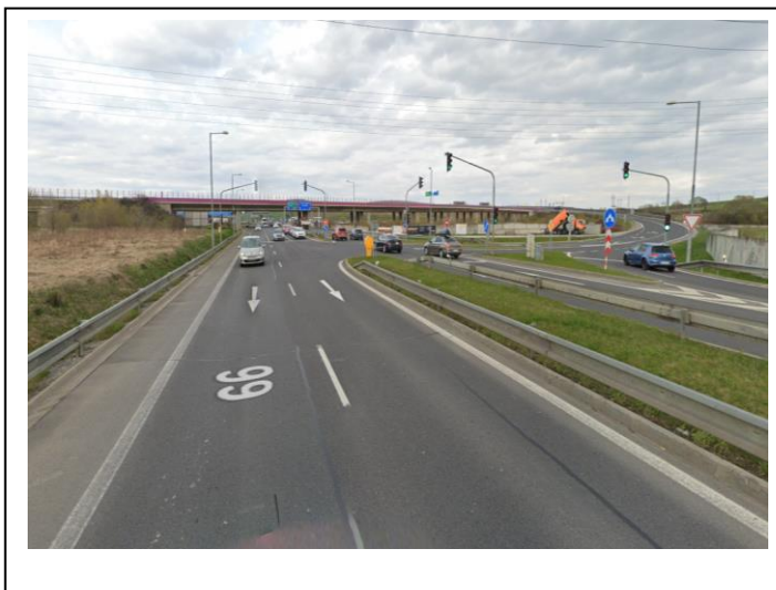
Začiatok úseku NL v smere staničenia
