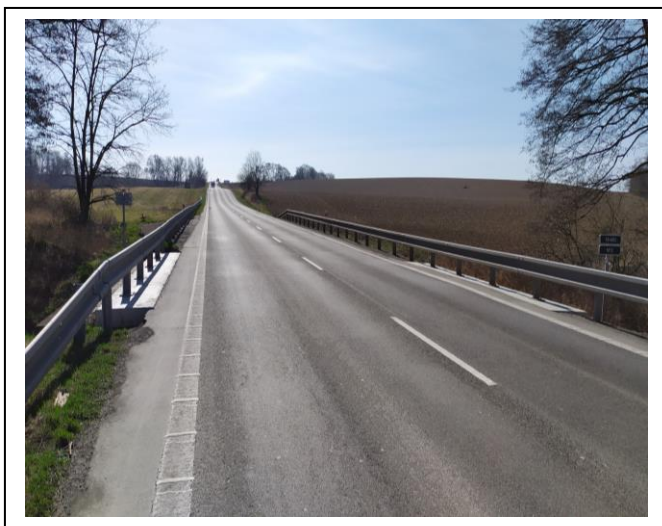
Začiatok úseku NL v smere staničenia
