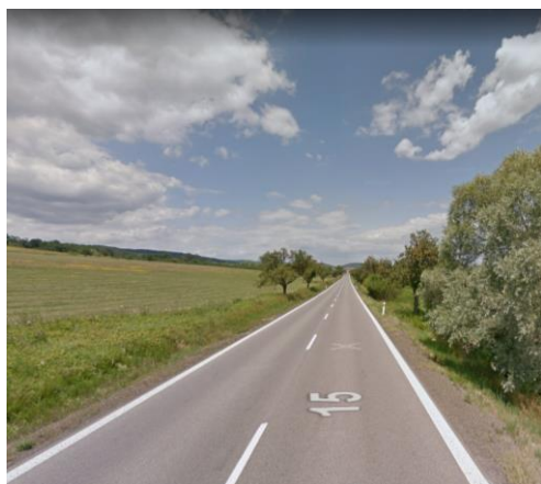
Začiatok úseku NL v smere staničenia
