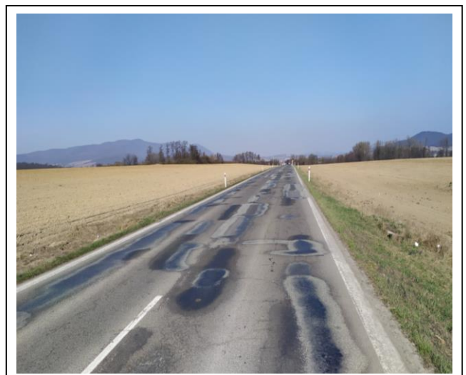
Koniec úseku NL proti smeru staničenia
