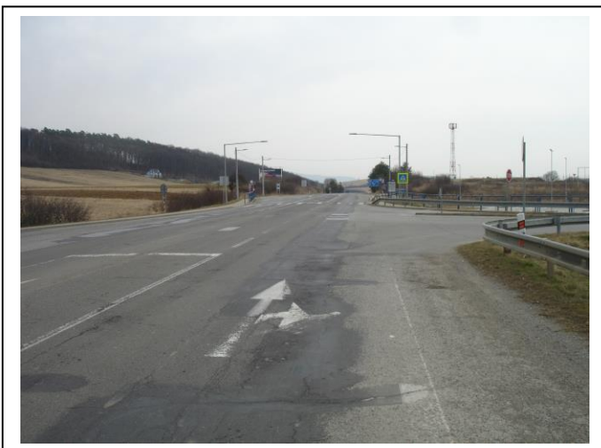
Začiatok úseku NL v smere staničenia
