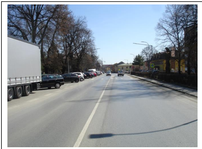
Začiatok úseku NL v smere staničenia
