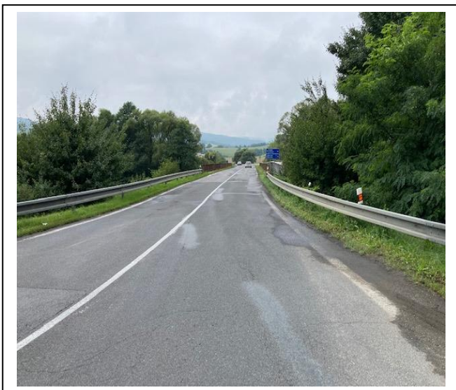
Začiatok úseku NL v smere staničenia
