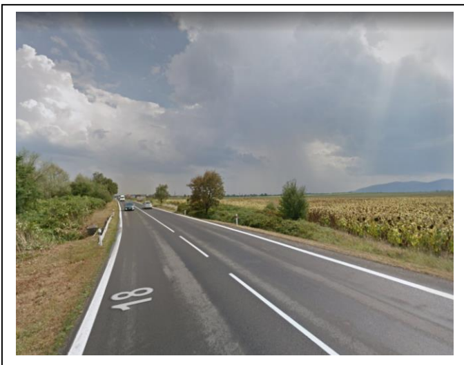
Začiatok úseku NL v smere staničenia
