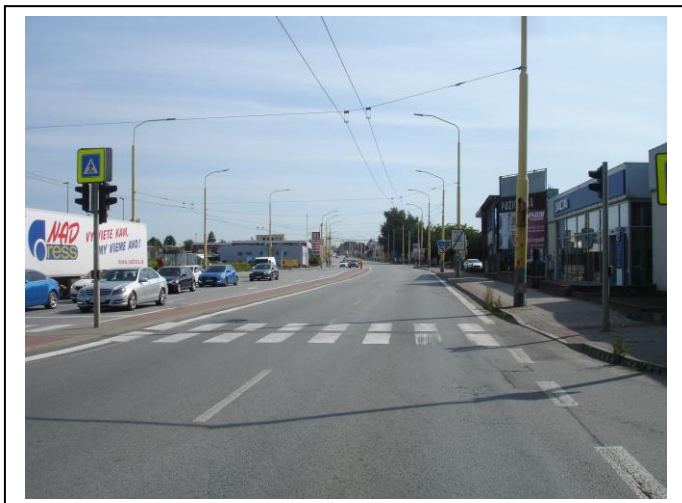
Začiatok úseku NL v smere staničenia
