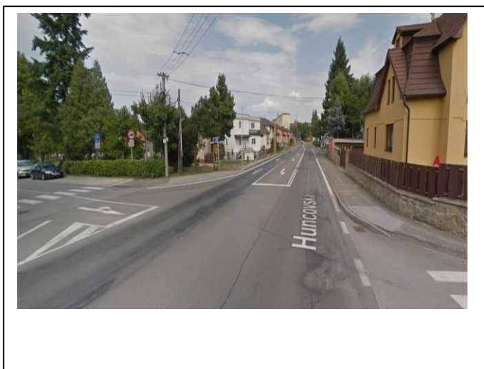
Začiatok úseku NL v smere staničenia
