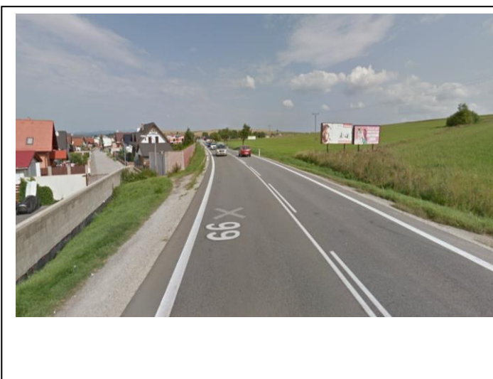
Začiatok úseku NL v smere staničenia
