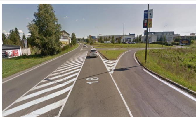
Začiatok úseku NL v smere staničenia
