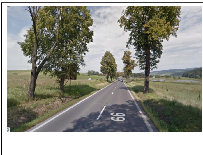
Začiatok úseku NL v smere staničenia
