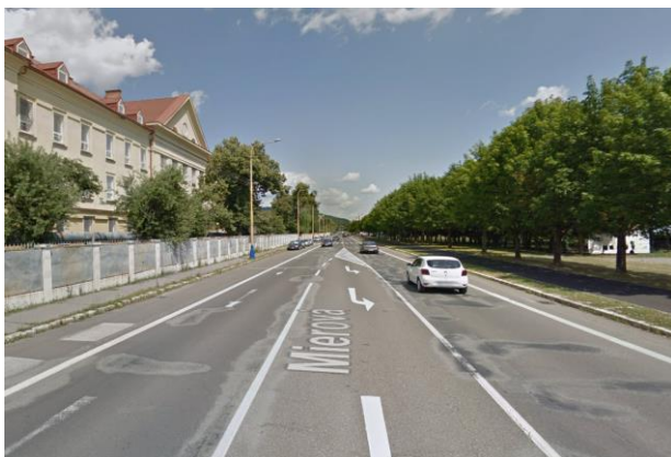
Začiatok úseku NL v smere staničenia
