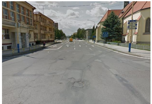
Koniec úseku NL proti smeru staničenia
