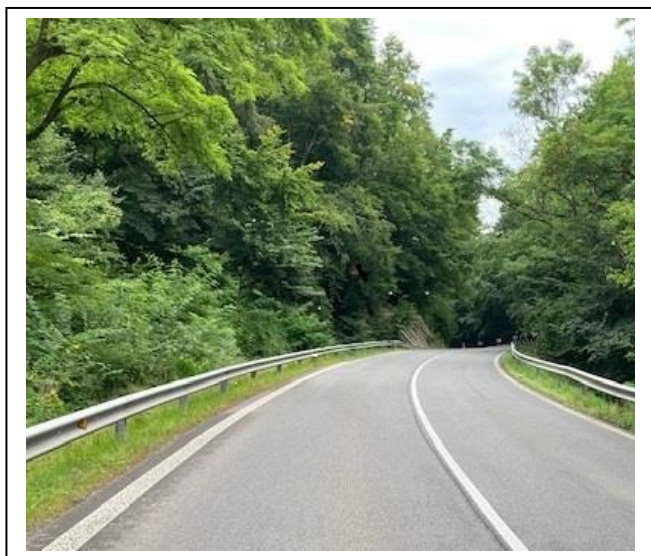
Začiatok úseku NL v smere staničenia
