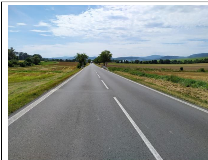
Začiatok úseku NL v smere staničenia
