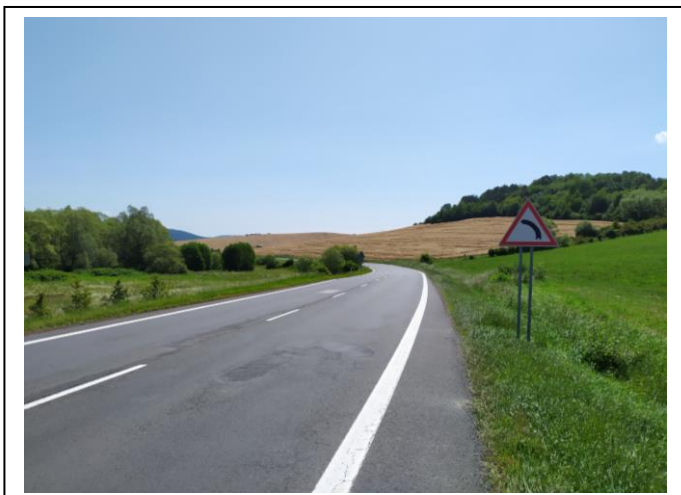
Začiatok kritického úseku v smere staničenia
