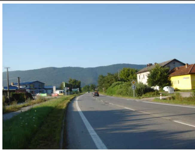
Koniec úseku KNL proti smeru staničenia
