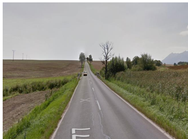
Koniec úseku KNL proti smeru staničenia
