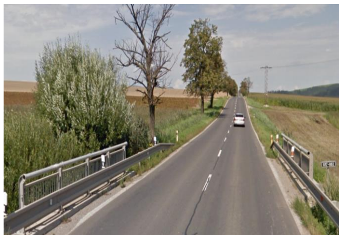
Začiatok úseku KNL v smere staničenia
