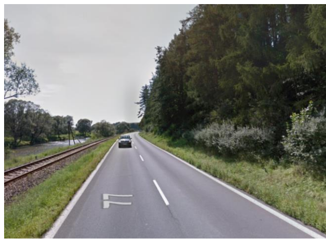
Koniec úseku KNL proti smeru staničenia
