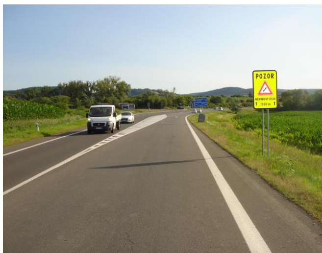
Začiatok úseku KNL v smere staničenia
