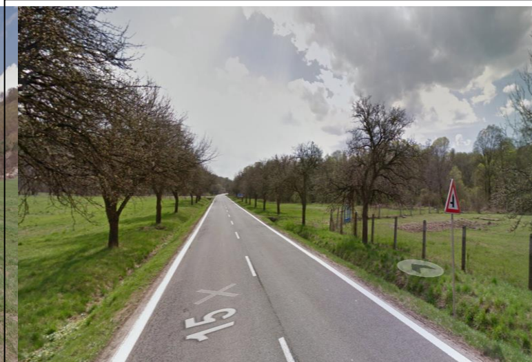
koniec úseku KNL
