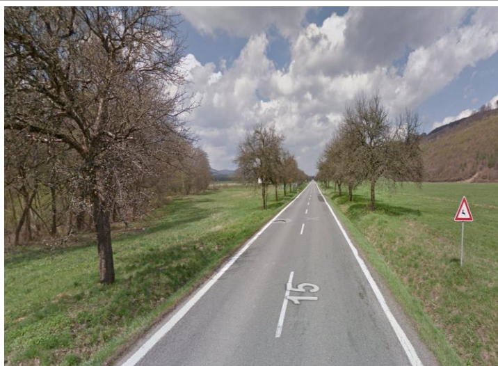
začiatok úseku KNL
