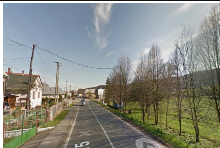
koniec úseku KNL
