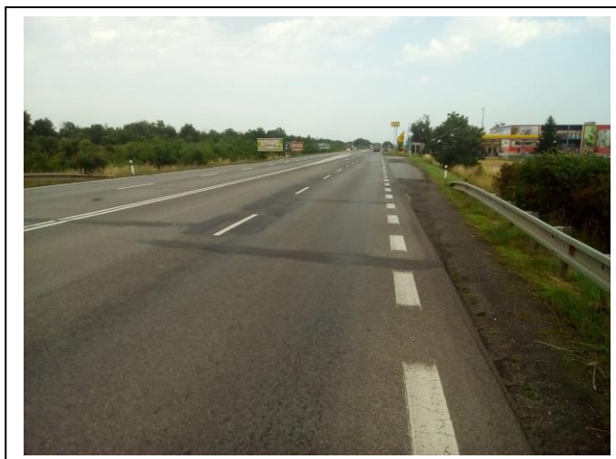
Koniec úseku KNL proti smeru staničenia
