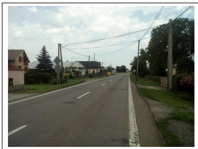
Koniec úseku KNL proti smeru staničenia
