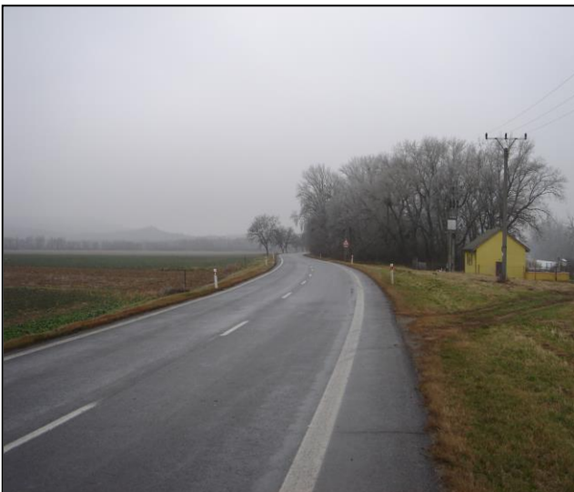
Začiatok úseku KNL v smere staničenia
