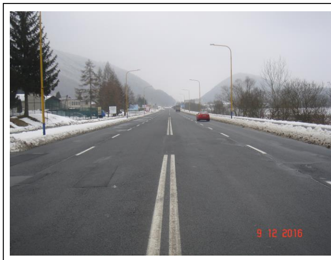
Koniec kritického miesta v úseku KNL
